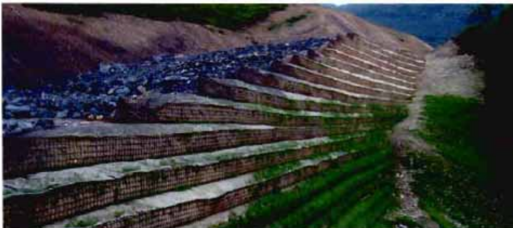
Estructura de suelo reforzado con geotextiles.
