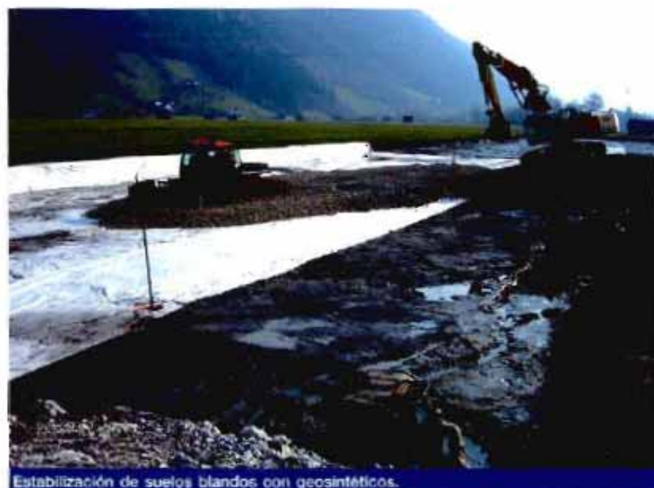
Estabilización de suelos blandos con geosintéticos.
