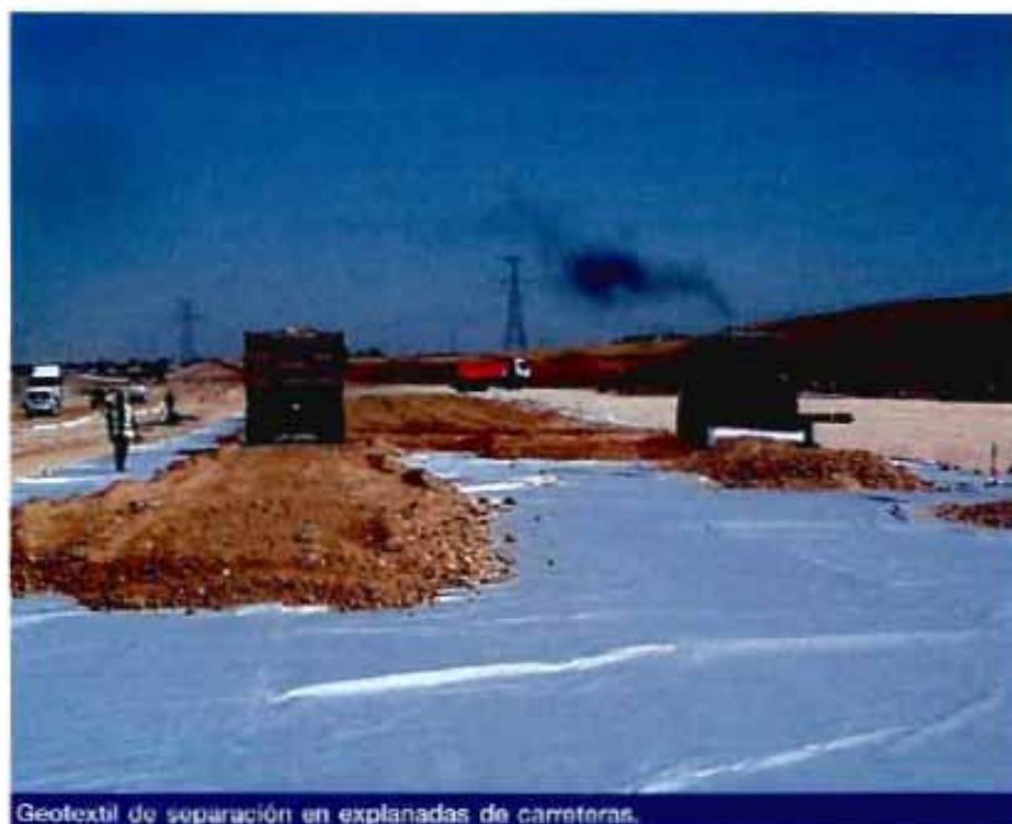
Geotextil de separación en explanadas de carreteras.
