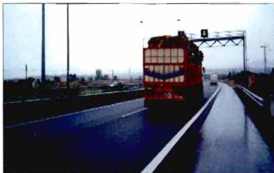
La utilización de mezclas drenantes mejoró notablemente las condiciones de circulación.
