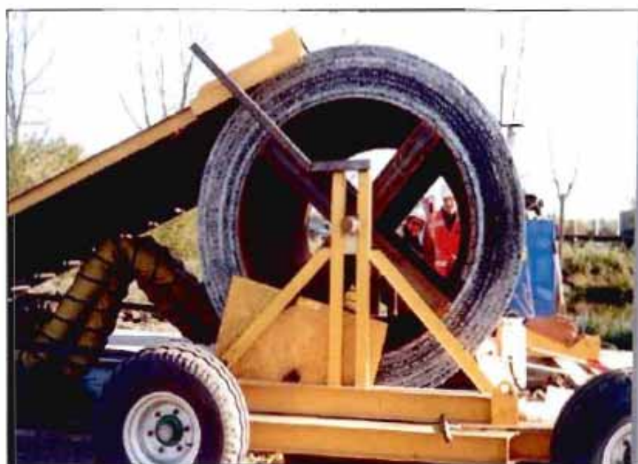
Construcción de un pavimento prefabricado, suministrado en forma de "alfombru".
