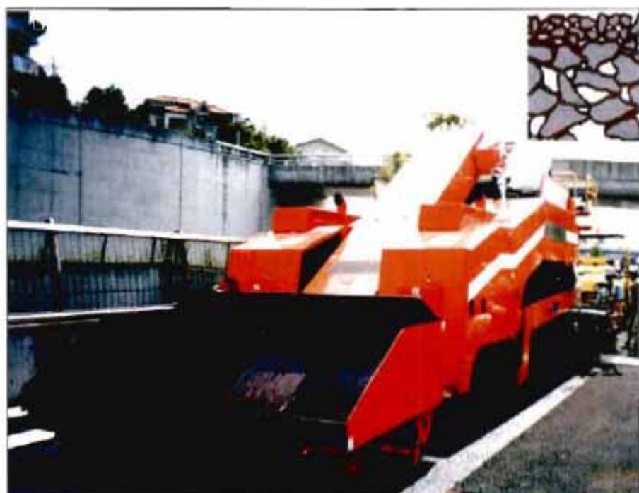
Equipo para la puesta en obra de las mejoras drenantes en doble capa.
