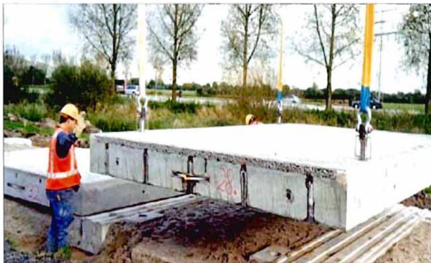
Construcción de un firme mediante módulos prefabricados.
