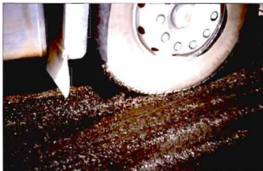
Circulación sobre riego de adherencia "termoadherente".
