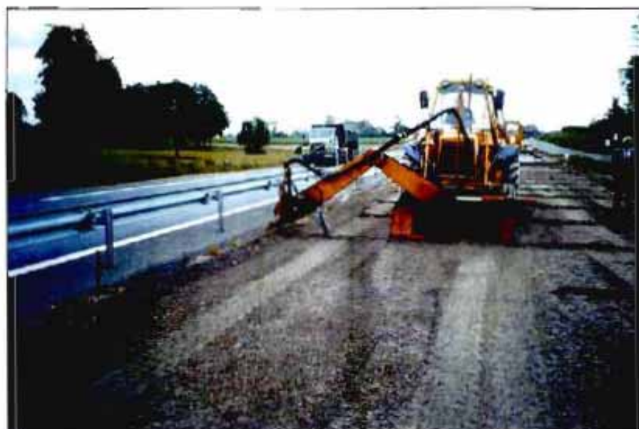
Preisuración en fresco de una gravacemento.
