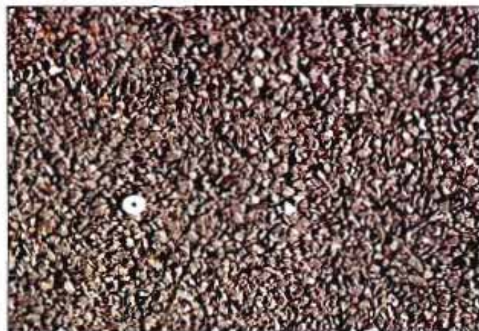
Tramo Pontevedra Sur - Rande. Pavimento drenante
