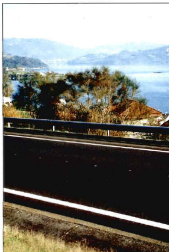
Tramo Pontevedra Sur - Rande, p.k. 145 + 200, dirección a Pontevedra
