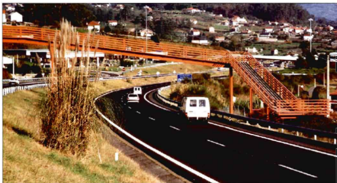
Tramo Pontevedra Sur - Rande (drenante) Dirección a Pontevedra, p.k. 145
