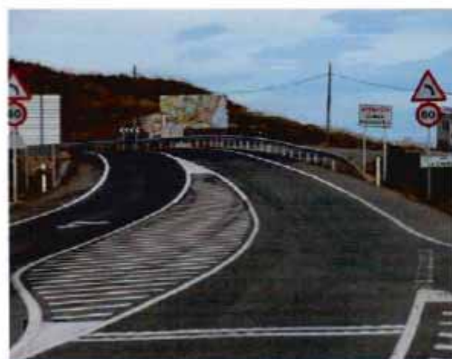
Foto 9. Vista de la curva corregida con refuerzo de señalización, balizamiento y defensas (en sentido a Murcia).
