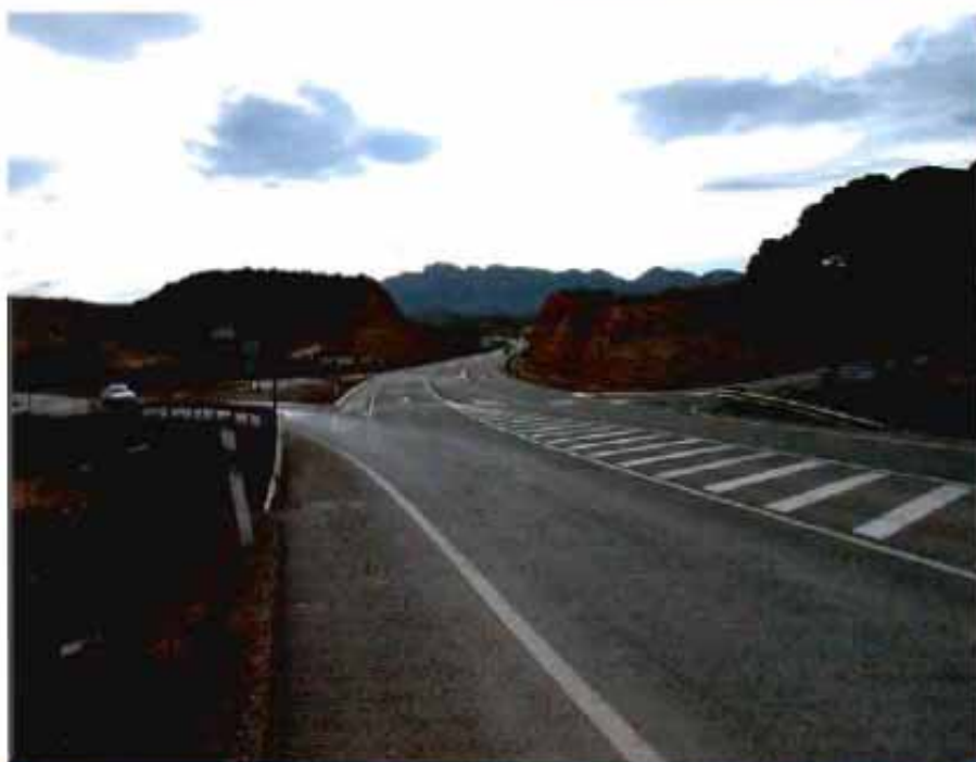
Foto 2. Tramo final acondicionado con intersección (A-332, en sentido a Almería).
