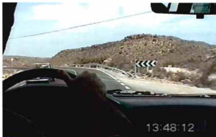
Foto 5. Detalle de la curva final con la barrera de seguridad tumbada por diversos accidentes (N-332, en sentido a Murcia).
