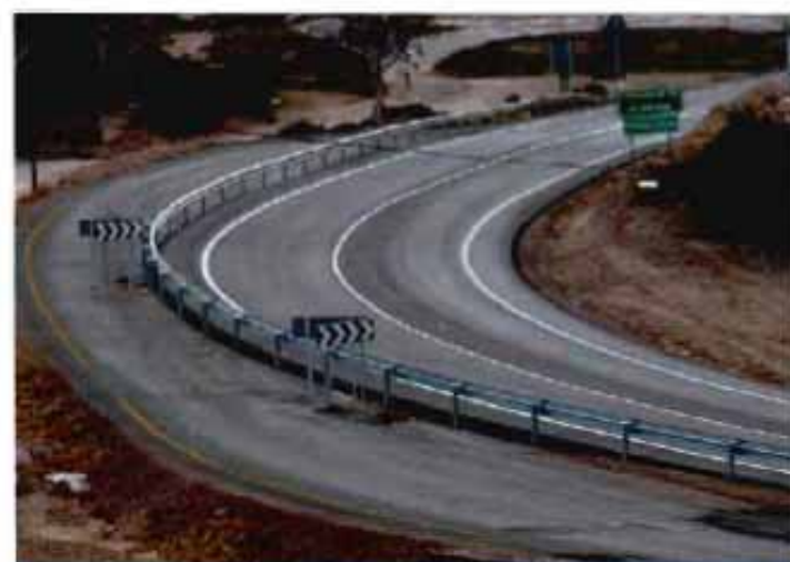
Foto 8. Detalle de la curva corregida con plataforma abandonada por unificación de curvas preexistentes y aumento de radio.
