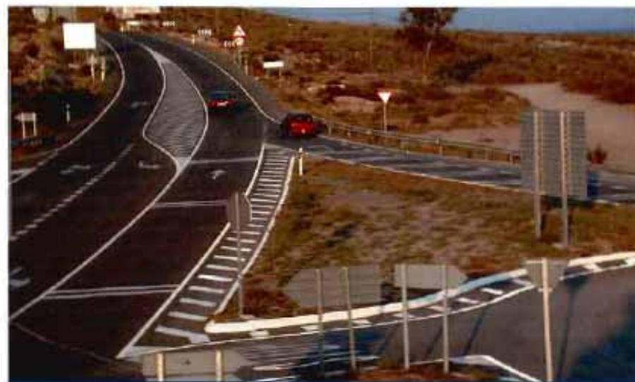
Foto 6. Tramo final acondicionado con intersección canalizada, bandus sonoras y curva con cambio de rasante con balizamiento (en sentido a Murcia).
