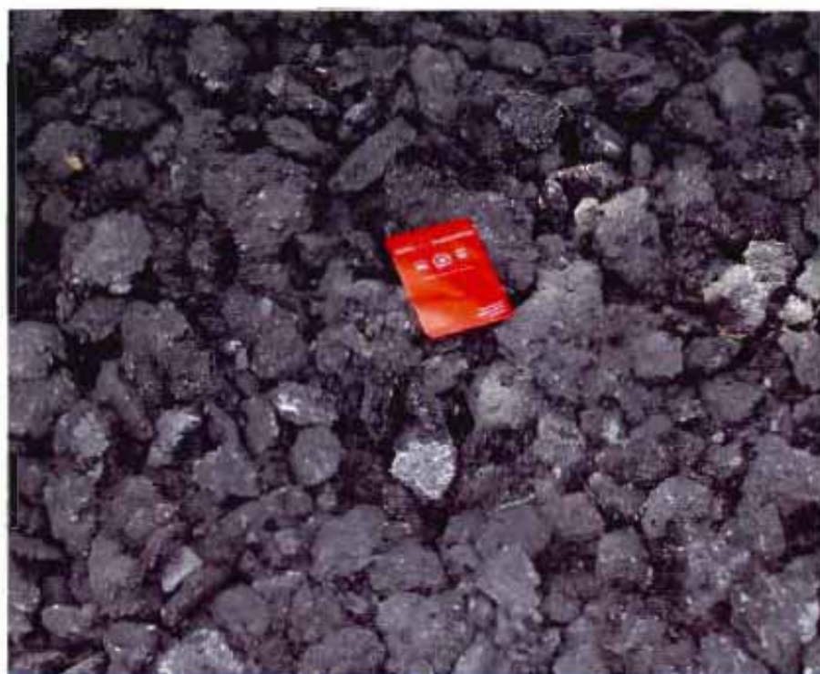
Mezcla asfáltica fresada para su posterior reciclado en central.
