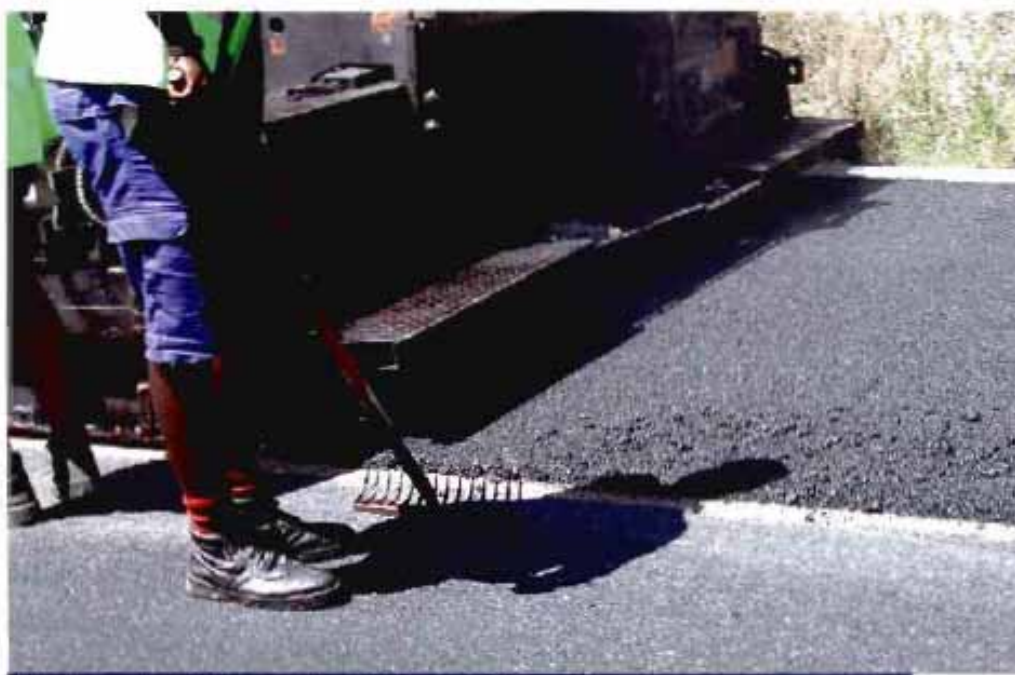
Puesta en obra de una mezcla asfáltica reciclada.
