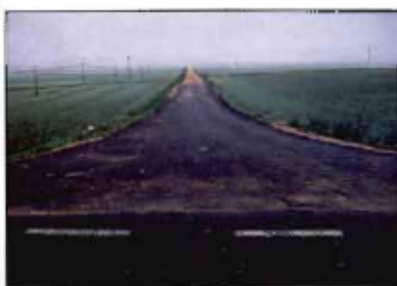
Los accesos a la carretera deben pavimentarse en unos 100 m
