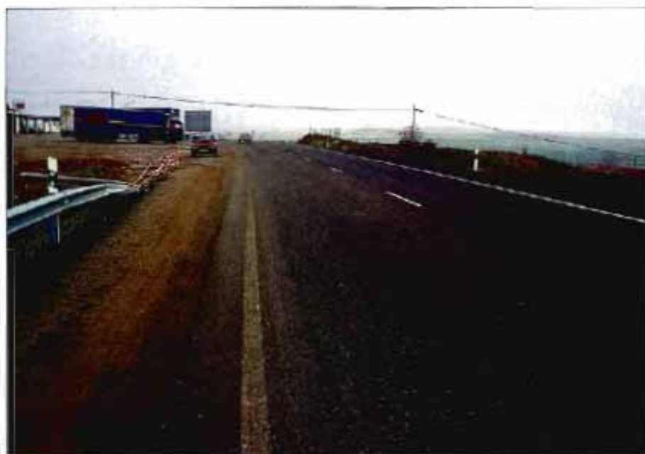
Colmatación debida a accesos sin pavimentar
