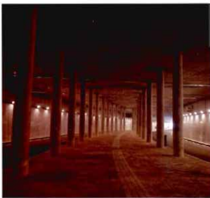
Interior del falso túnel. Tramo A.
