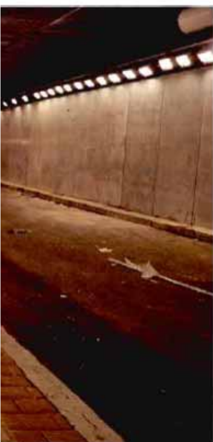
Interior del falso túnel. Tramo C.
