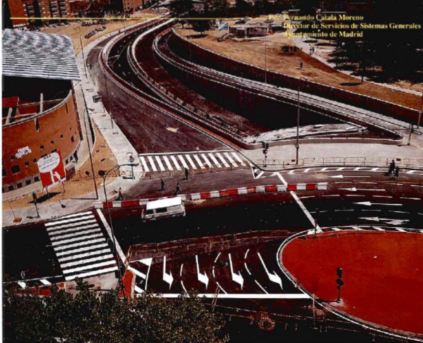
Glorieta de c/ Antonio Machado y boca Norte del Paso Inferior.
