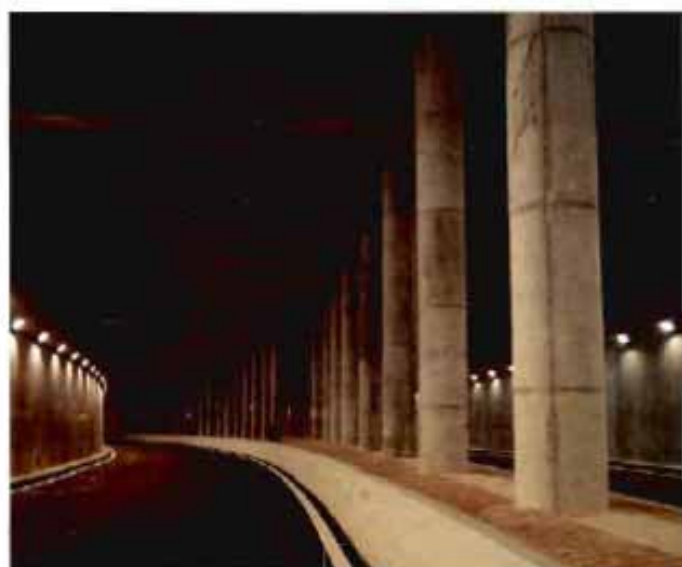
Interior del falso túnel. Tramo B.
