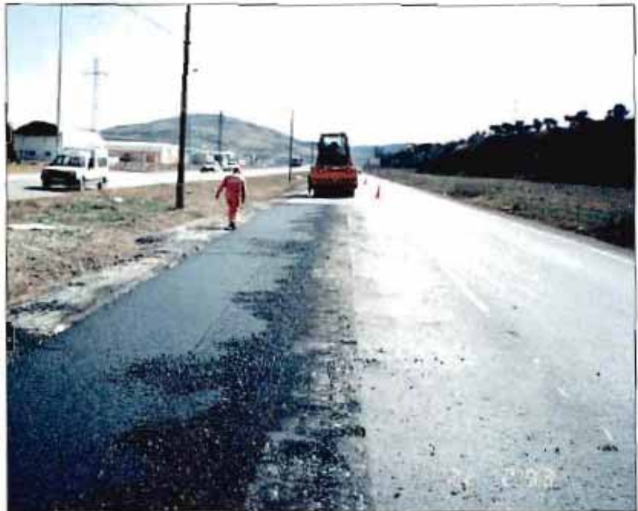
Operación de mantenimiento: fresado y extendido de mezcla bituminosa.
