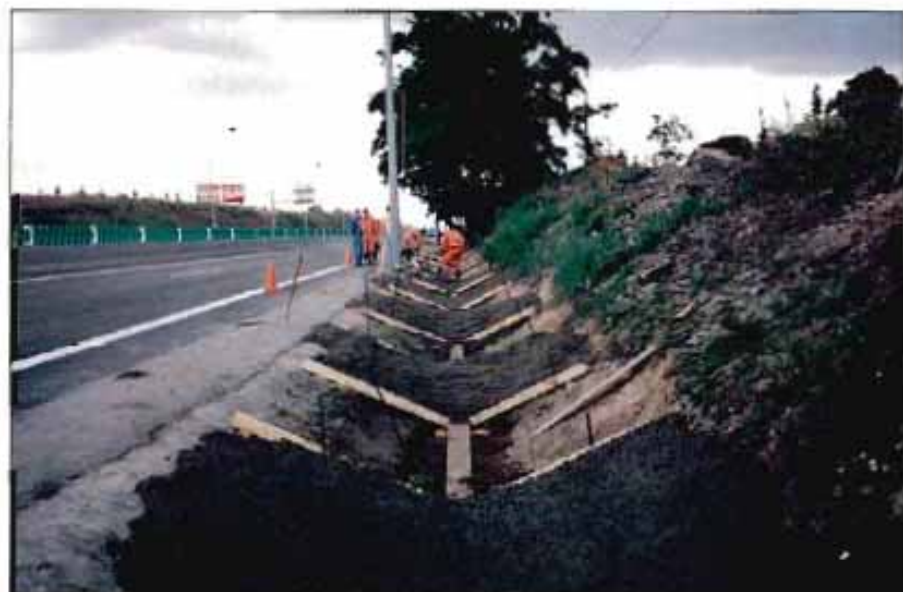
Operación de mantenimiento: revestimiento de cunetas.
