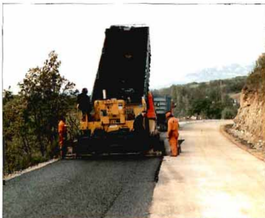
Operación de reconstrucción.
