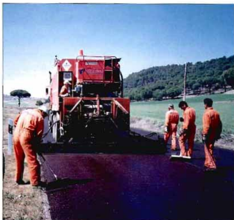
Operación de mantenimiento: tratamiento superficial.
