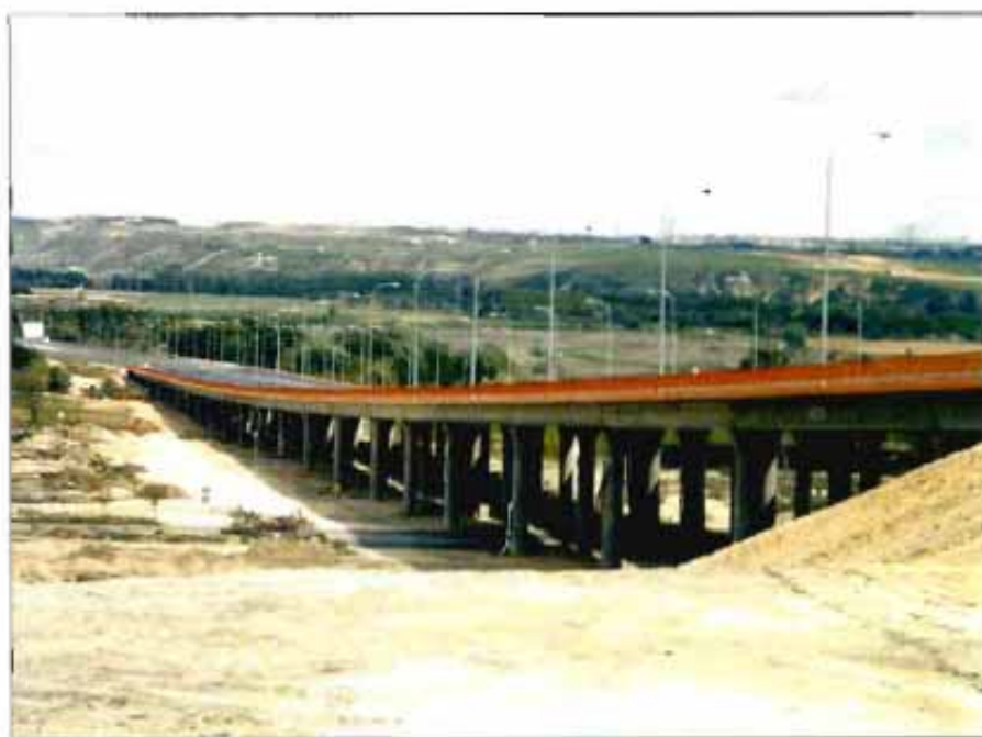
Viaducto del Jarama
