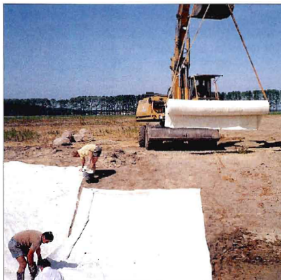
Refuerzo de un terraplén
