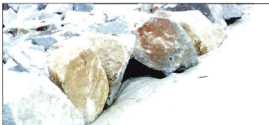
Deterioro durante la instalación
