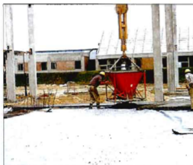
Geotextil en edificación.
