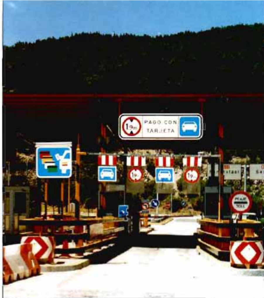
Cabina de peaje de pago con tarjeta.
