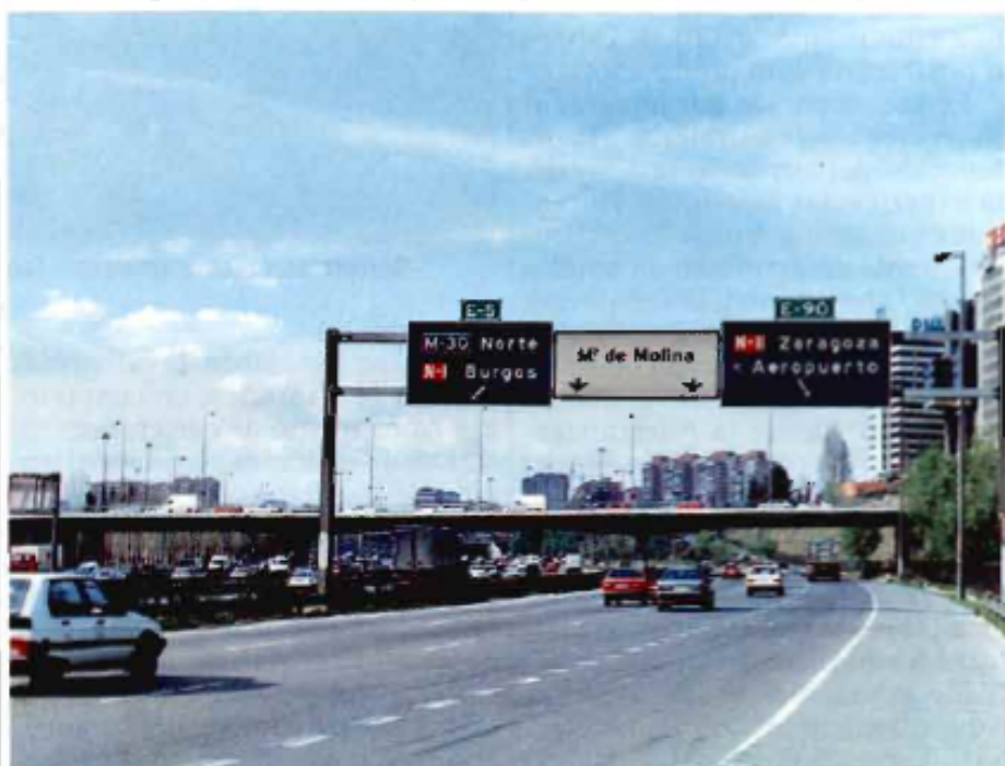
La necesaria integración de una carretera en el medio que atraviesa. M-30 Madrid.
