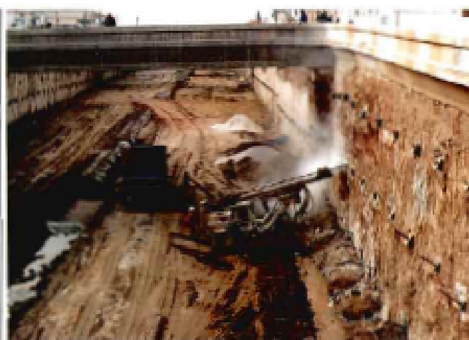
Foto 4. Perforaciones para Mechinal.
