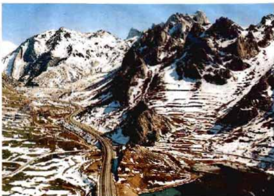
Las A.S.V.E. pueden contemplarse como un salto cualitativo en la concepción de autopistas, con un costo más alto pero no disparatado. En la foto, una vista parcial de una autopista de montaña.
