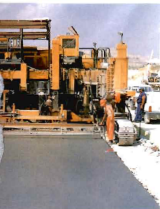
a autovía ya finalizada, del Plan General de Carreteras.
