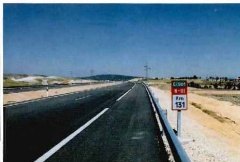
Figura 8. Autovía N-III y su espectro de amplitudes. Excelente terminación y acabado. IRI menor de 1,5 en el tramo analizado.
