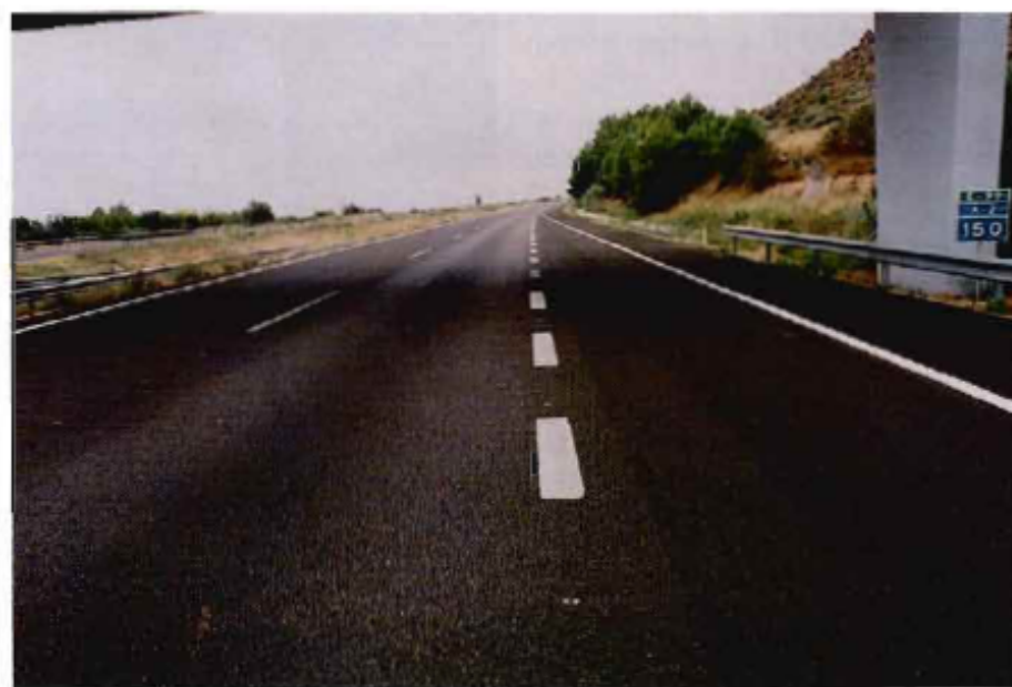
Figura 9. Autopista A-2. Excelente terminación y acabado. IRI menor que 1.
