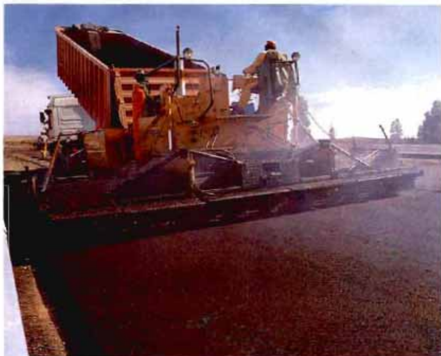
En la foto se aprecia la fase de extendido, la cual es muy importante para el resultado final de la carretera, y de su regularidad superficial.
