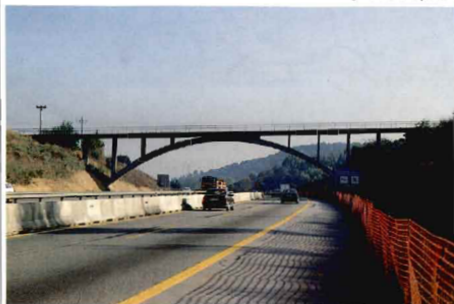
Fig. 4. Puente en arco
