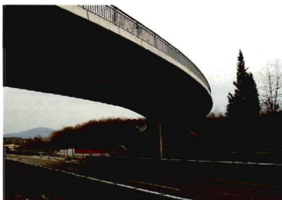
Fig. 9. Puente curvo sobre apoyos puntuales.
