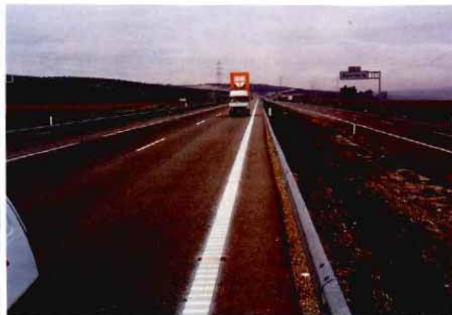
Señalización horizontal: perfiles escalonados como nuevos materiales, que además de su efecto sonoro, mejoran la visibilidad en periodos de lluvia.
