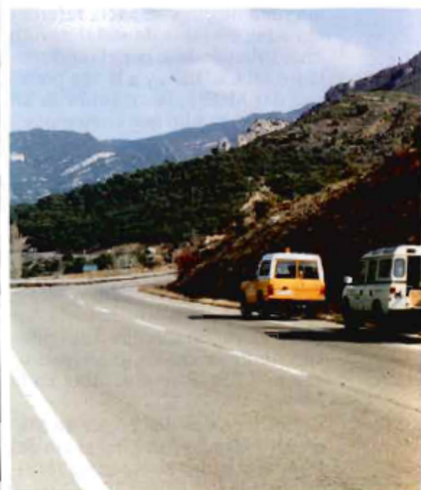
Señalización vertical: panorámica de la inspección
