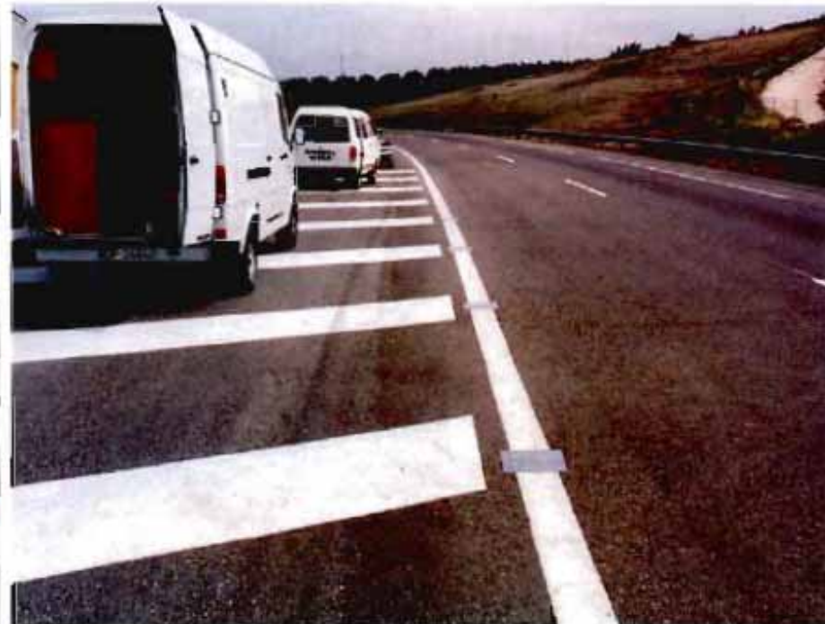
Señalización horizontal: toma de muestra durante la aplicación de las marcas viales.
