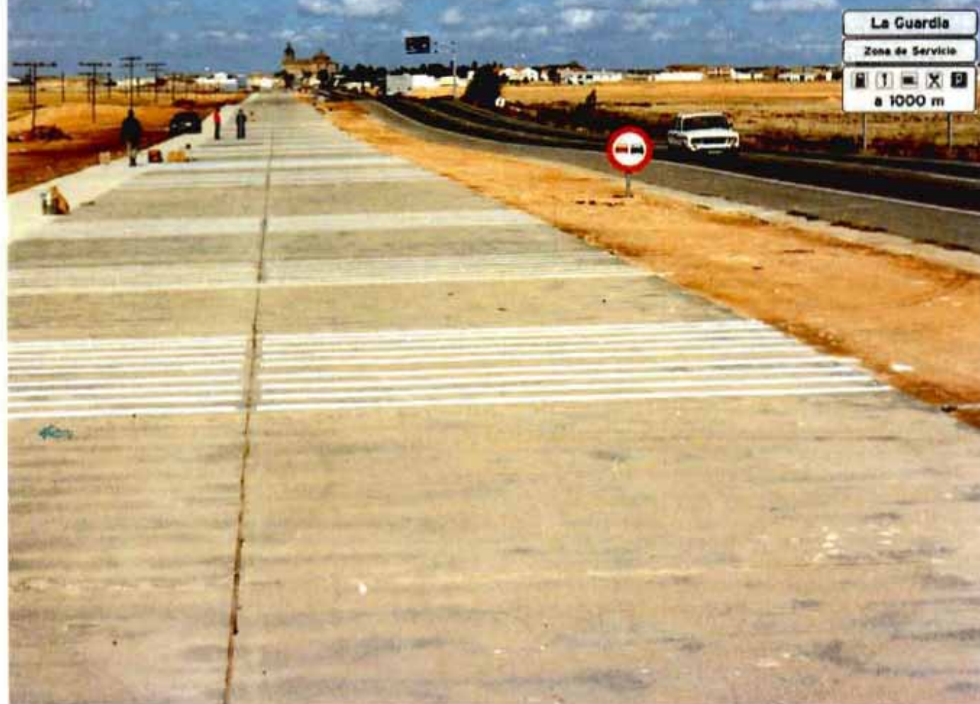
Señalización horizontal: campo de pruebas experimental situado en la N-IV para la comprobación de la idoneidad de marcas viales.
