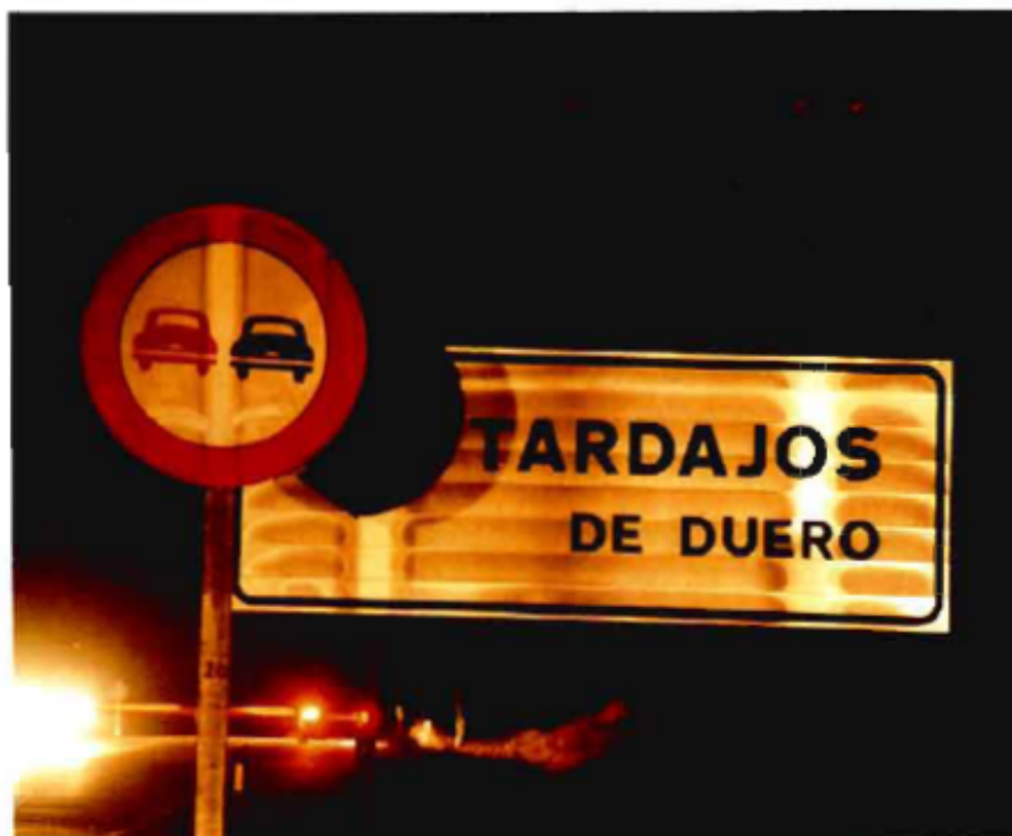
Señalización vertical: campo de pruebas experimental situado en la N-111 en la provincia de Soria, donde se está llevando a cabo un estudio sobre el efecto de las condensaciones en la visibilidad nocturna.
