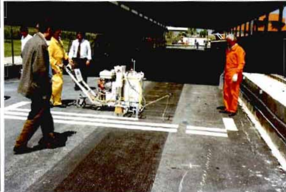
Señalización horizontal: aplicación de nuevos materiales en la pista de ensayos de firmes del Centro de Estudios de Carreteras del CEDEX.
