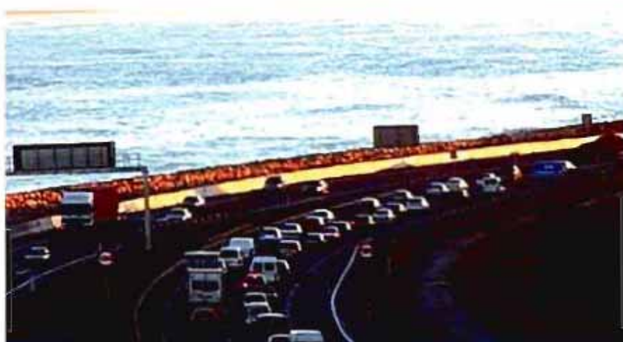
Fig. 4.- Vista de la V-21 a su entrada en la ciudad de Valencia (fuente: cámaras del CGT Valencia)
