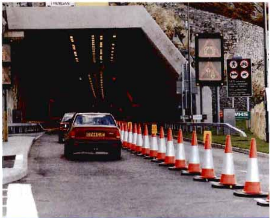
La Directiva aprobada se refiere a todos los túneles de más de 500 m de longitud que estén en la Red Transeuropea de Carreteras.
