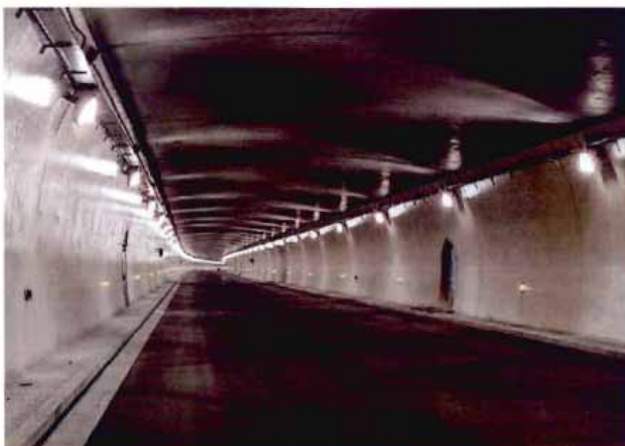
La Directiva aborda el problema de los accidentes en los túneles de carretera desde un punto de vista sistemático abarcando, entre otros, el trazado y el diseño de los túneles, en especial su iluminación y el acabado de sus superficies vistas.
