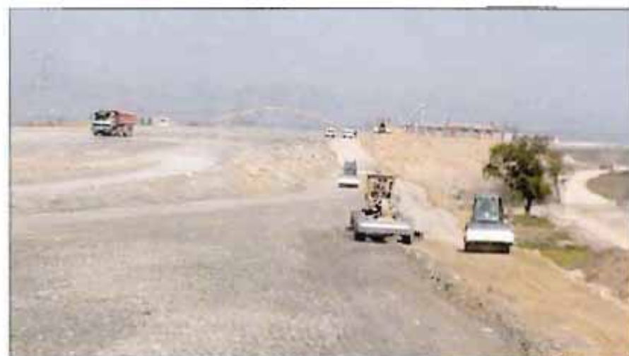
Compactación simultánea de núcleo (Peñuelas) y espaldón.
