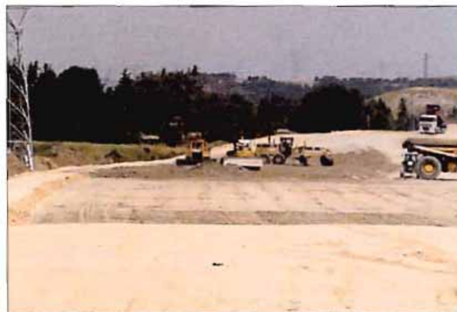
Extendido de capa de núcleo de sandwich.
