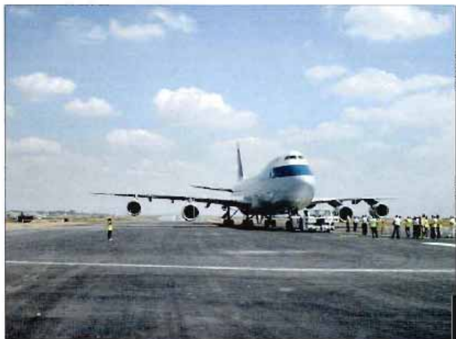
Comprobación final y prueba de carga de la pista
