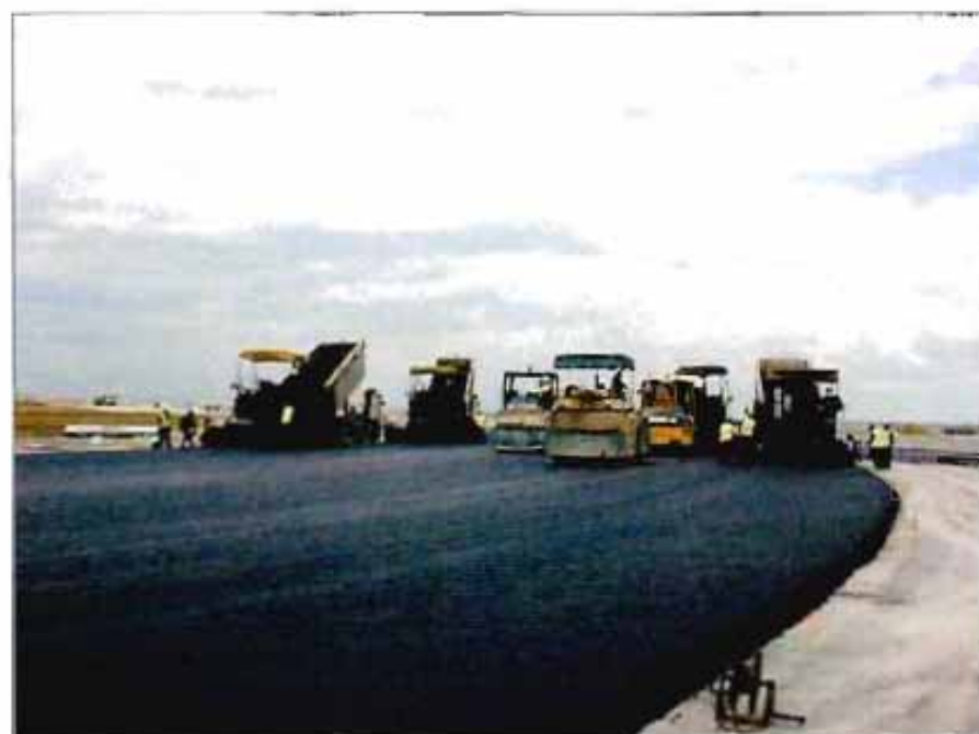
Extensión de la base asfáltica de alto módulo.
