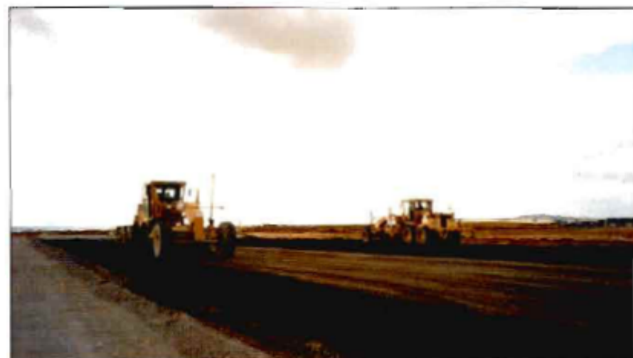
Extensión de la grava tratada con ligante hidráulico.
