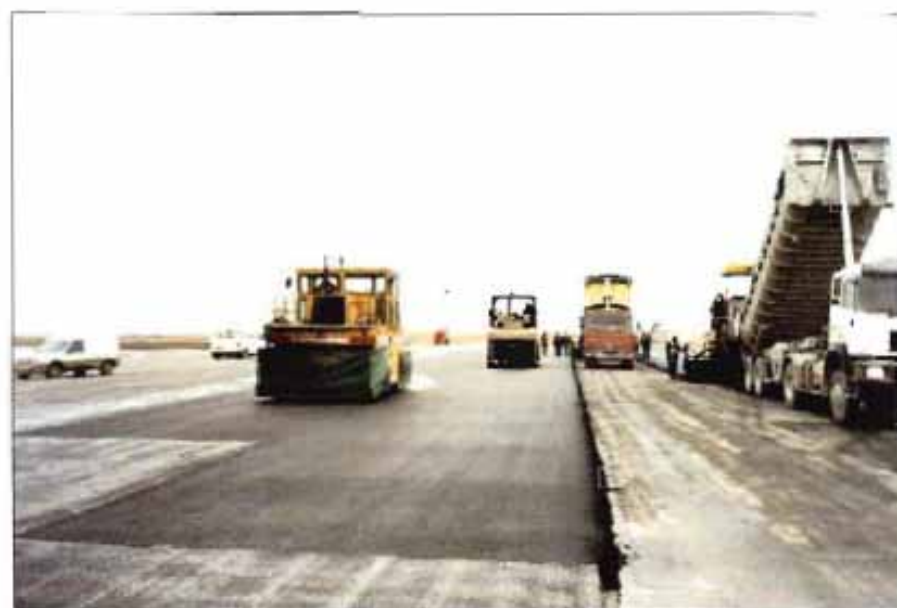
Aspecto de una junta de trabajo en la capa de base.
