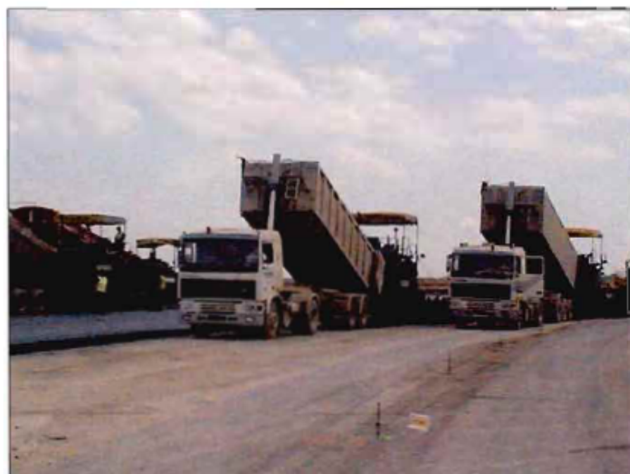
Extensión de la base asfáltica.
