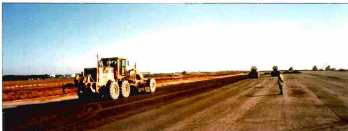
Refino y compactación de la grava tratada
