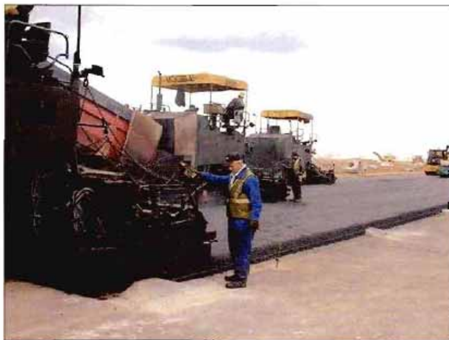
Interferencia de las bases de balizas al colocar la 2ª capa de base
