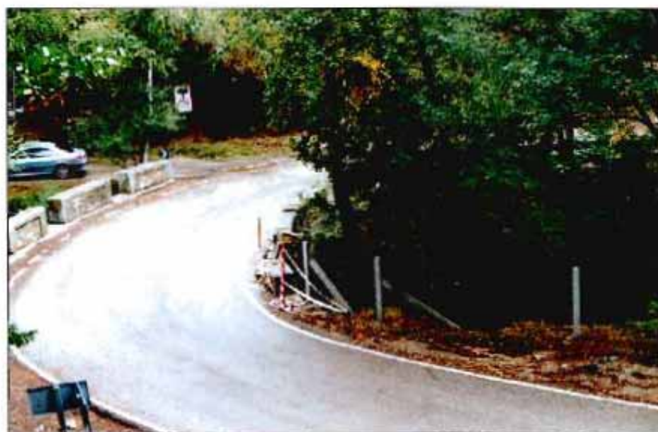
Figura 11. Carretera M-629: huellas de un reciente accidente en una curva de radio reducido (p.k. 9.659)
