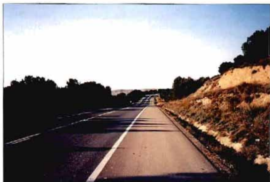
El impacto ambiental de una vía está asociado a la superficie afectada.
