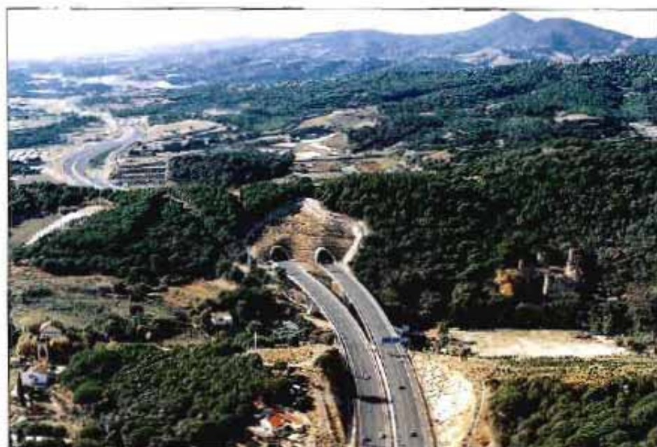
Autopista Interurbana A-19 (E 6) con tres carriles por sentido.
