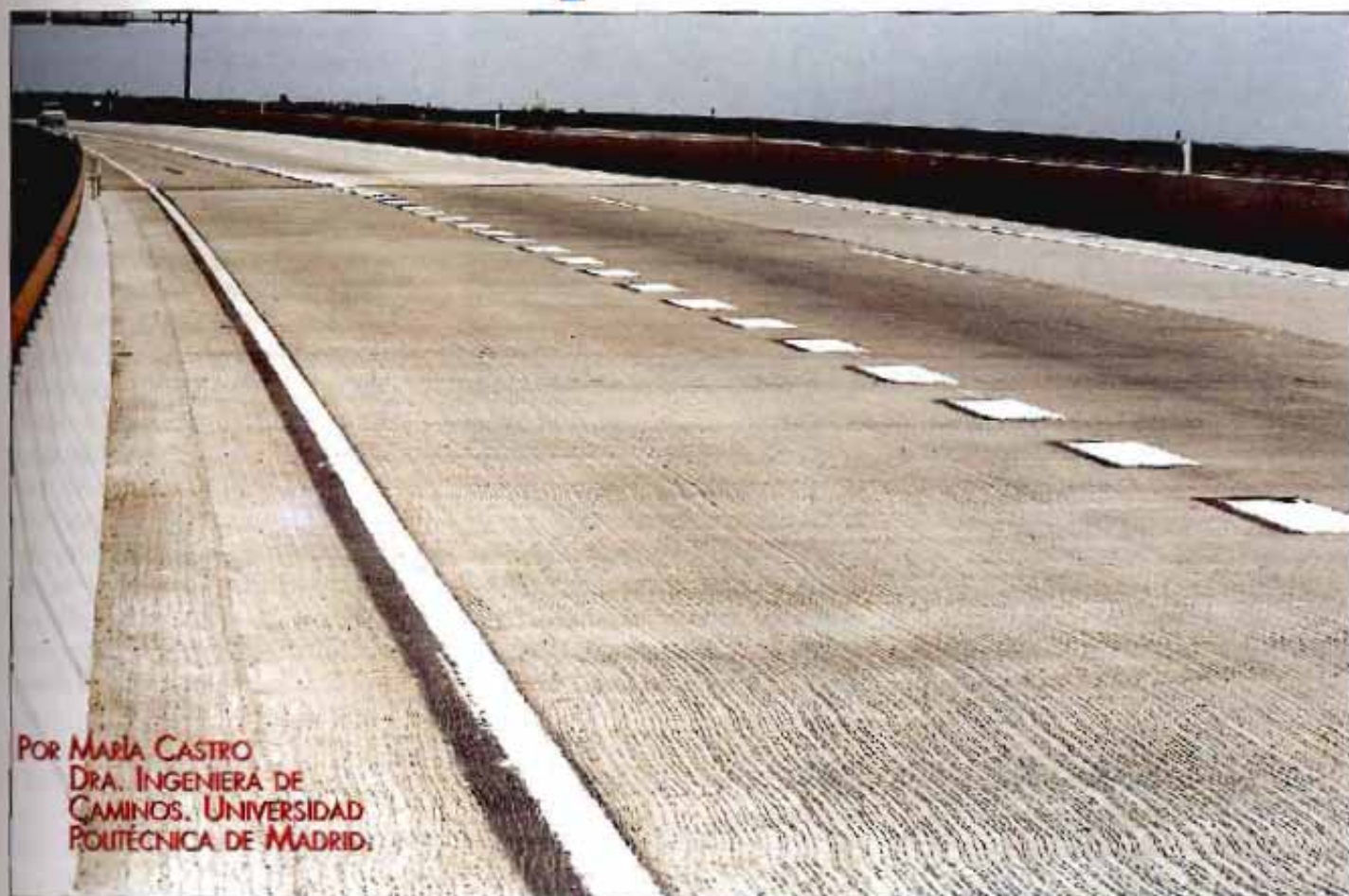
Figura 1. Pavimento de hormigón adherido sobre una de las estructuras de la variante de Arganda.
