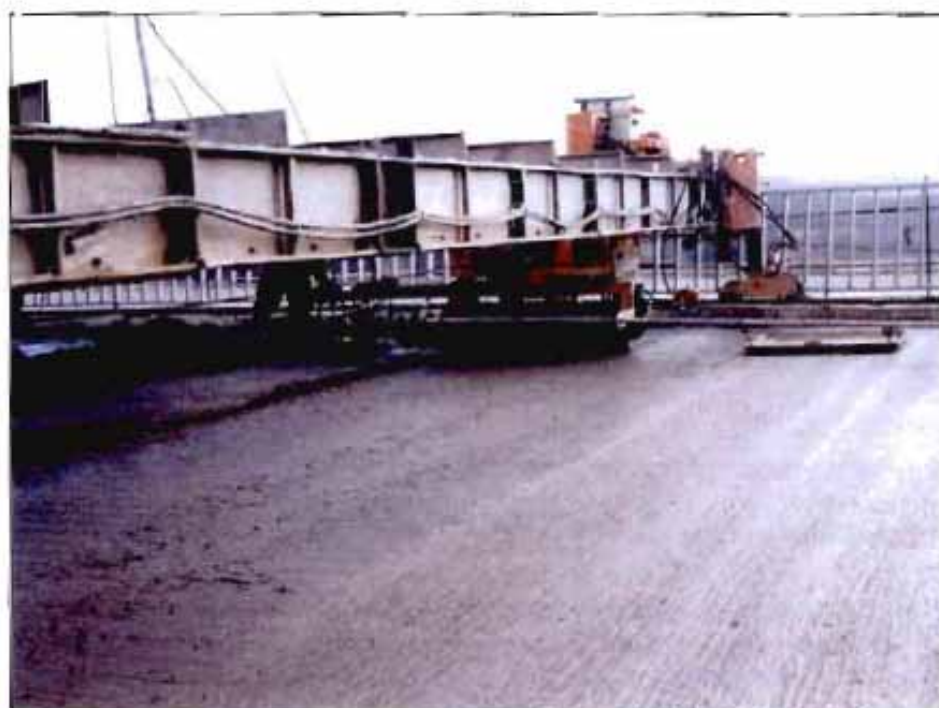
Figura 5. Pavimentación de uno de los tableros del viaducto de Valladolid [1].
