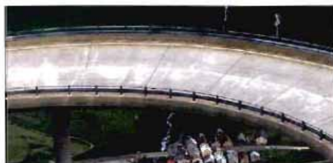
Figura 7 Pavimento de hormigón en Suiza (San Gotardo-Fontana)
