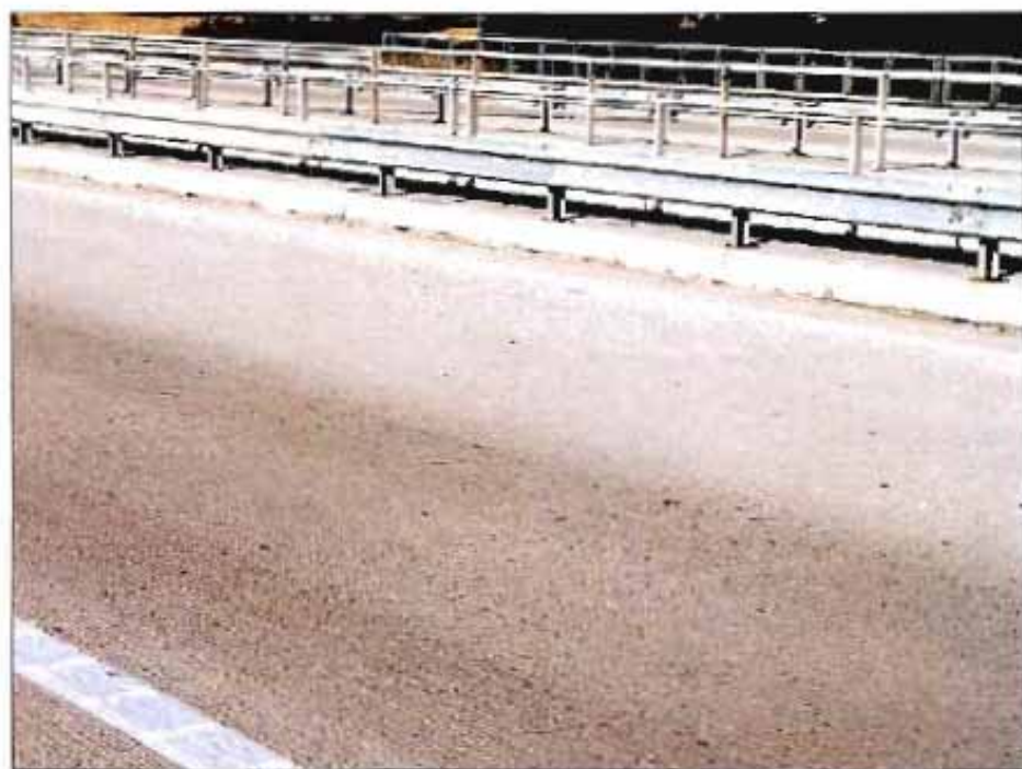
Figura 3. Pavimento incorporado (autopista Tarragona-Valencia-Alicante).
