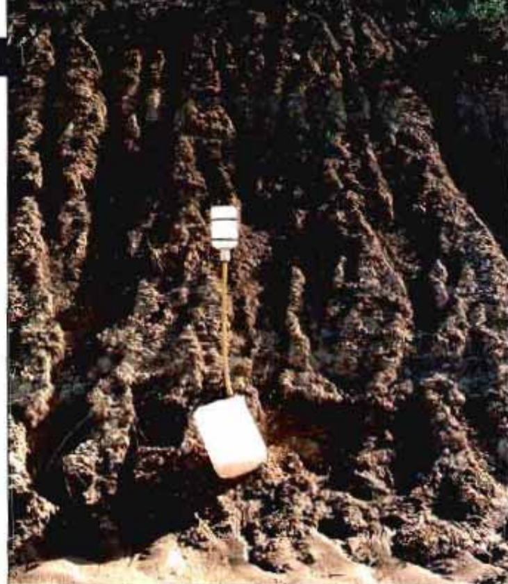
Foto 4. La tormenta del 15/7/97 erosionó gravemente los taludes, transformando su dinámica erosiva.
