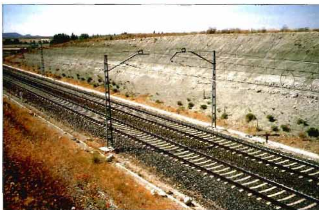
Foto 2. Aspecto de los desmontes de ferrocarril estudiados, después de diez años de su construcción.
