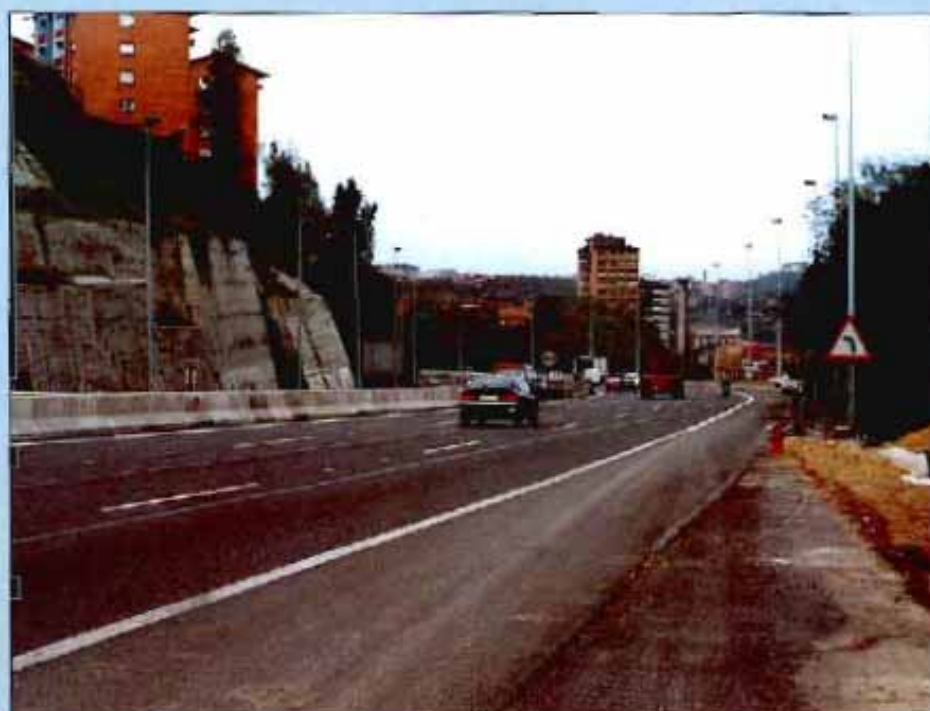
Otro tramo de pruebas de la A-8.
