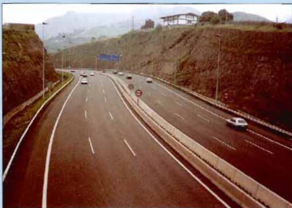
Vista parcial de la A-8, en sentido a San Sebastián. Poste 20 m.
