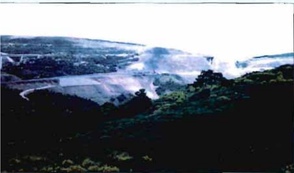
Foto 10. Visión del conjunto de las obras comentadas.
