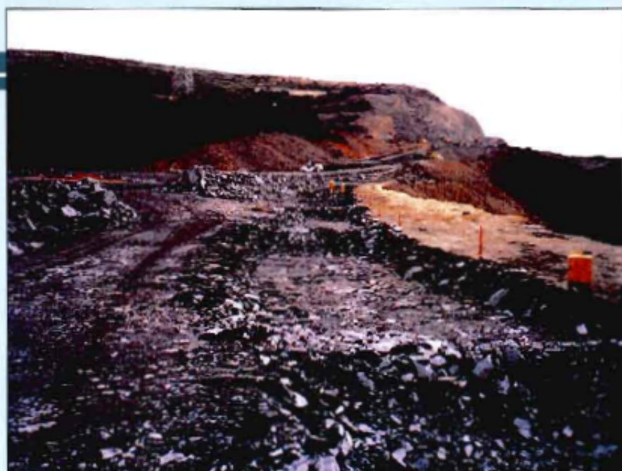
Foto 9. Aspecto del todo-uno de filitas una vez puesto en obra.
