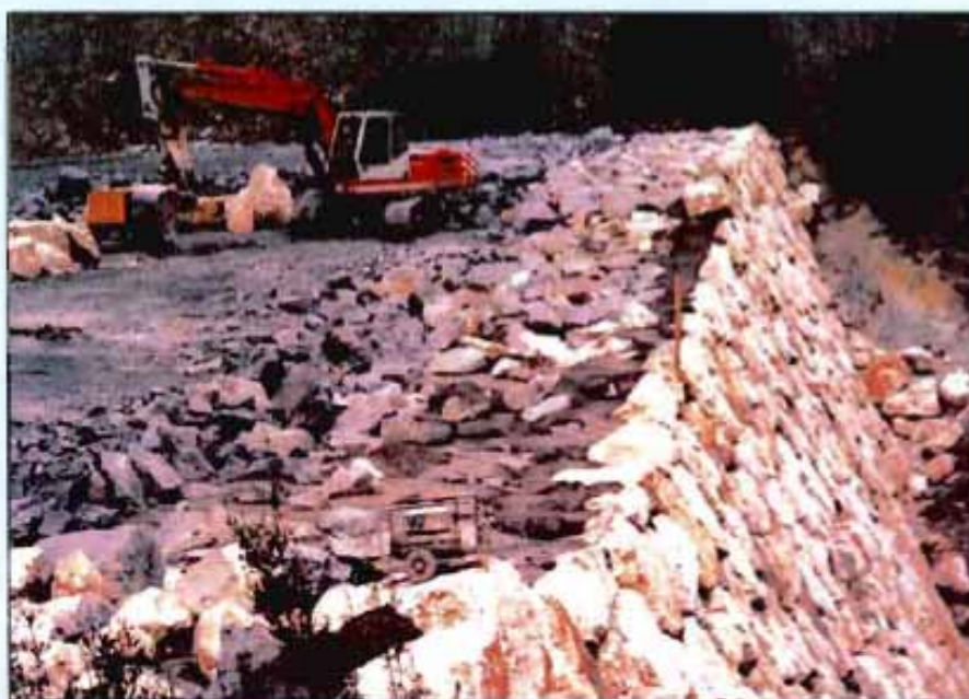
Foto 8. Proceso de ejecución del muro de escollera situado en el pie del terraplén.
