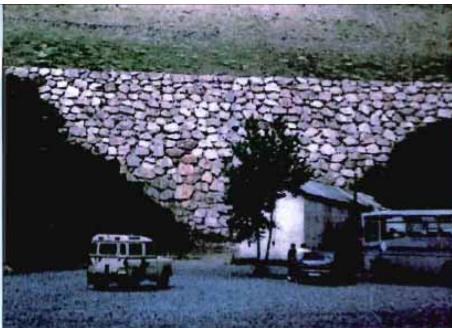
Foto 7. Vista de la obra desde su pie de aguas abajo.
