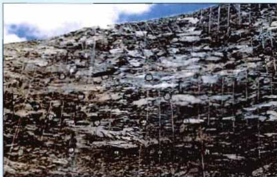
Foto 6. Aspecto actual de talud. Disposición de las medidas de refuerzo.
