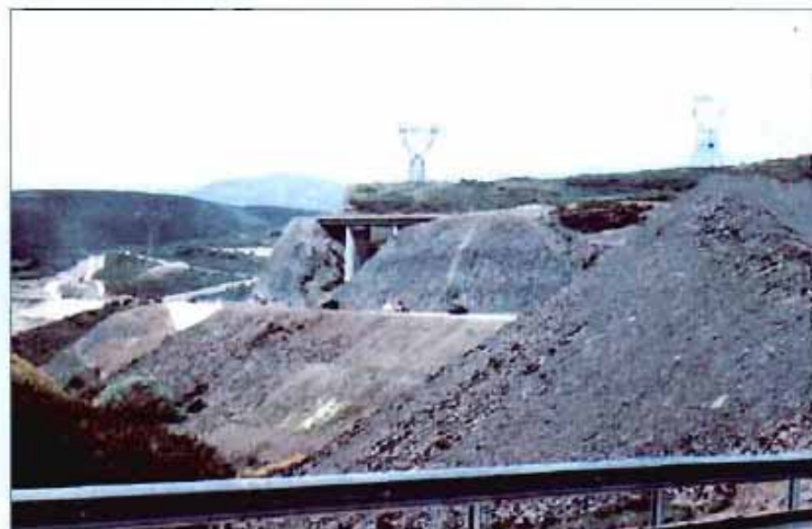
Foto 2. Panorámica de la zona una vez realizadas las excavaciones.
