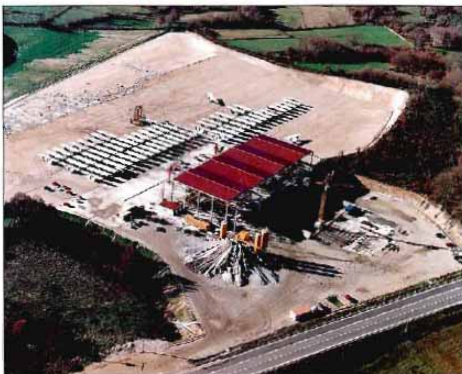
Para la construcción se separaron los trabajos de fabricación y montaje.
