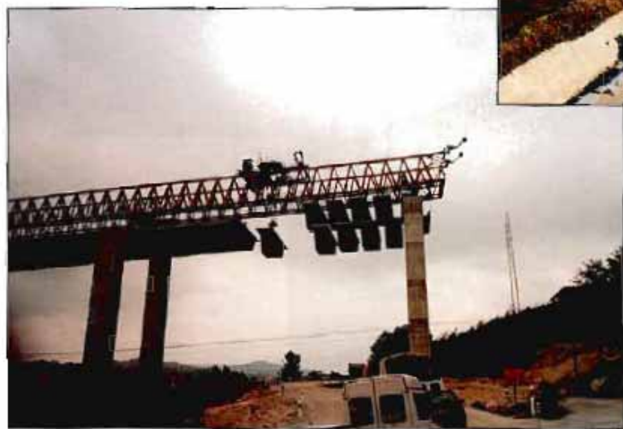
Las dovelas encajaron perfectamente.
