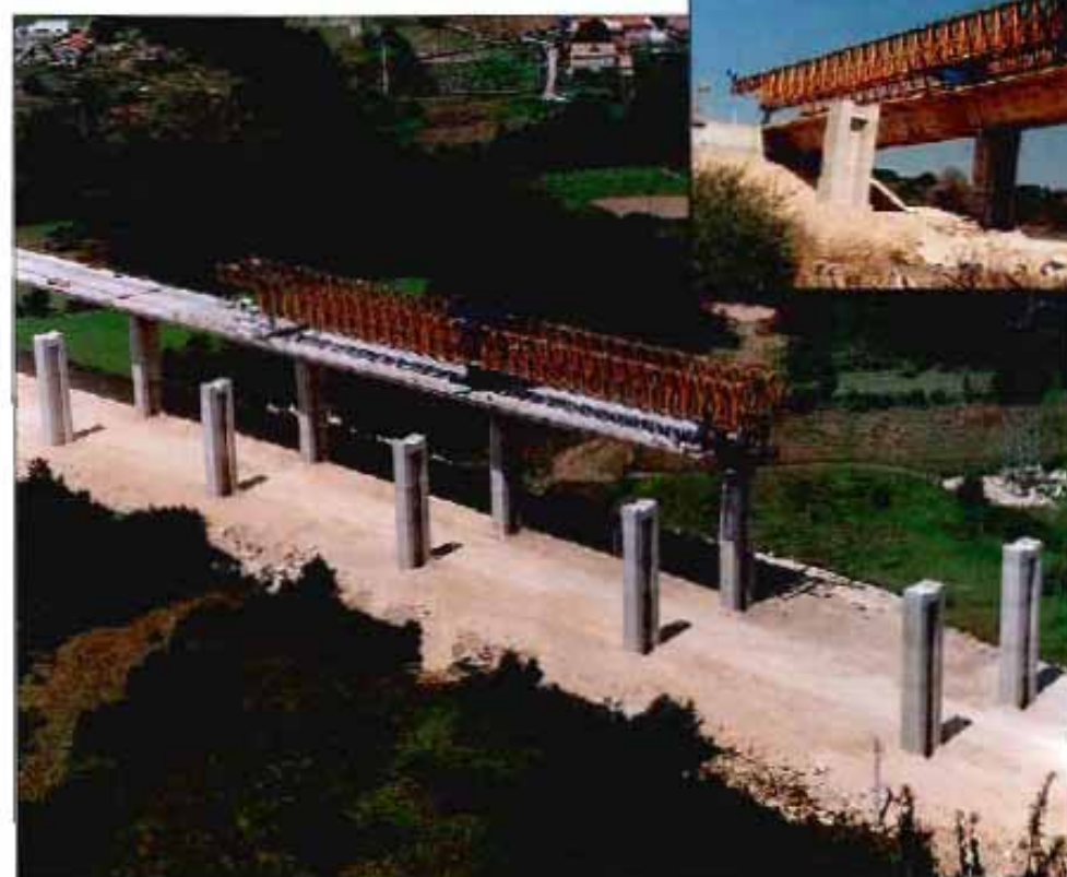
Distintas fases del proceso constructivo del viaducto de Arnoyo.
