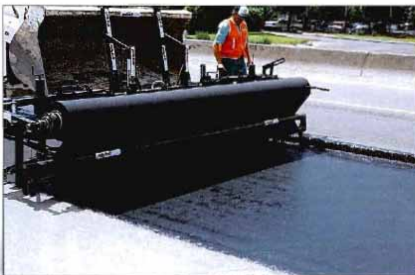
Foto 8. Ejecución de una membrana antifisura SAMI utilizando geotextil impregnado con emulsión modificada tipo ECR-3m.
