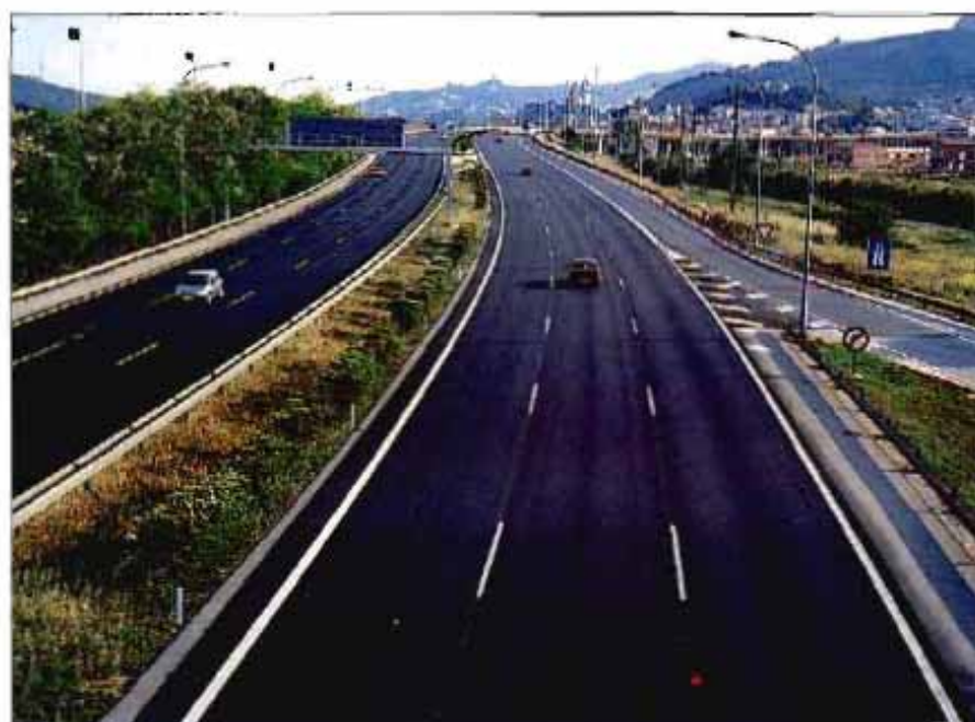
Foto 4. Vista general de un microaglomerado discontinuo en caliente empleado en autopista y fabricado con betún BM-3c.
