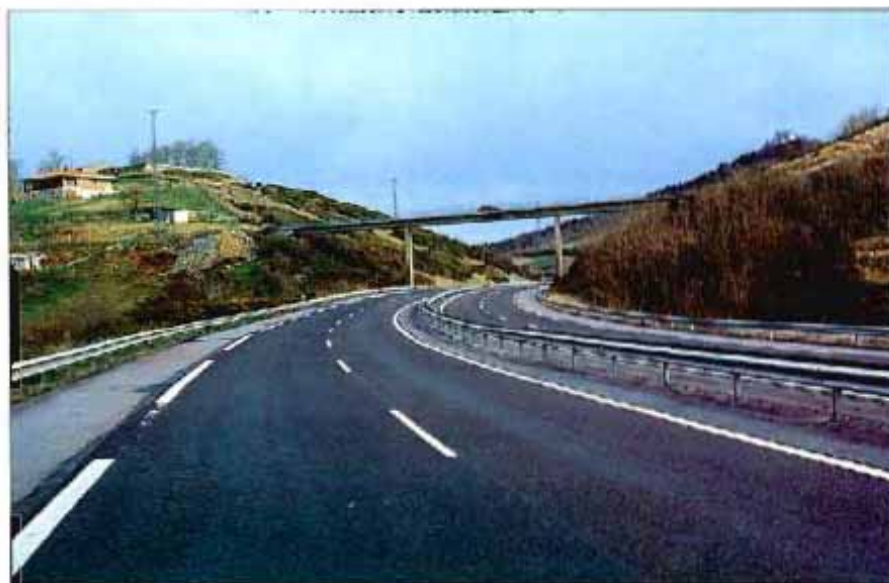
Foto 10. Aspecto de un microaglomerado en frío ejecutado en una autopista mediante empleo de una emulsión ECL-2m
