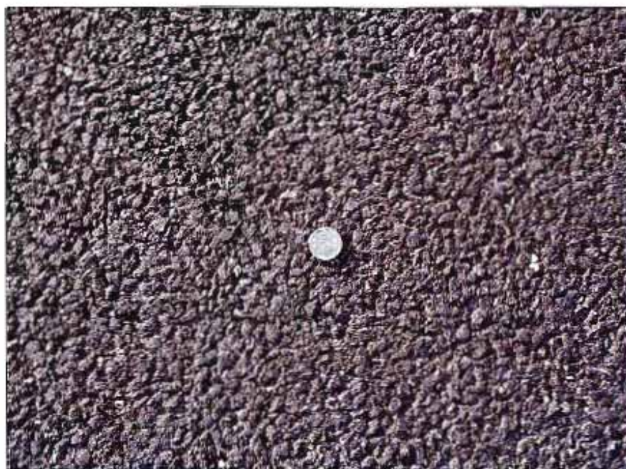
Foto 3. Aspecto superficial de una mezcla discontinua para capa de rodadura de pequeño espesor (microaglomerado en caliente) fabricada empleando betún modificado
