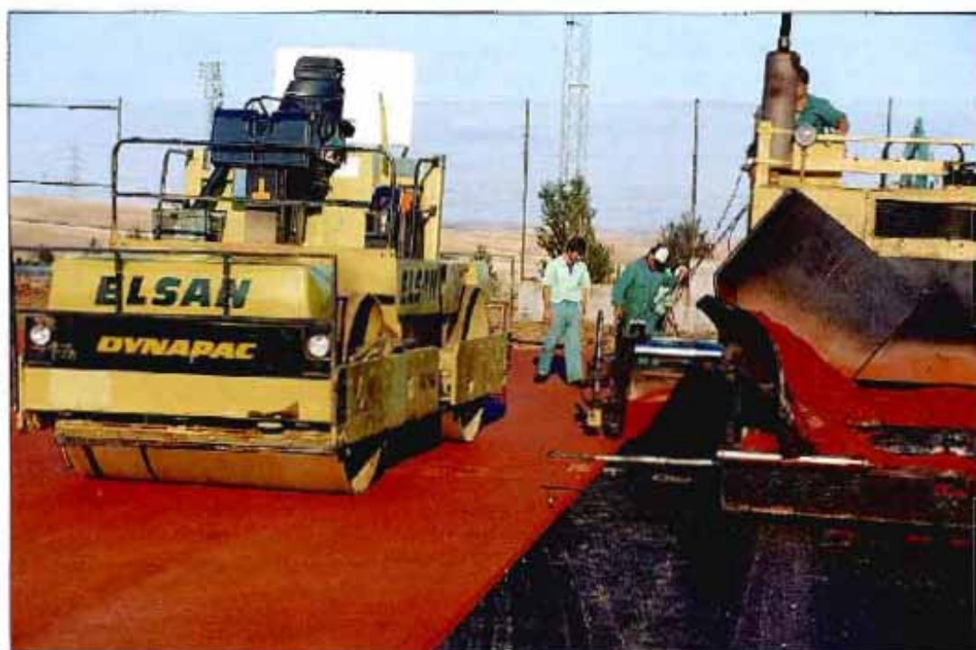
Foto 12. Ejecución de un pavimento deportivo mediante el empleo de un aglomerado fabricado con betún sintético (Alcobendas).
