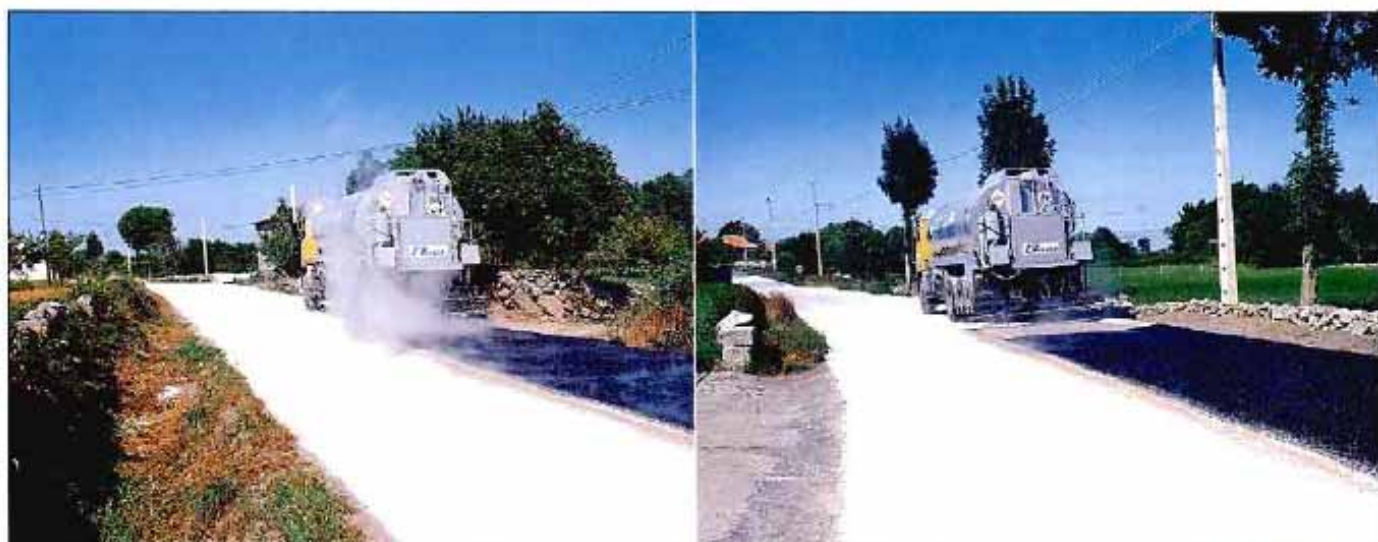
Foto 6. Ejecución de un tratamiento superficial con grava empleando emulsión modificada tipo ECR-3-m.
