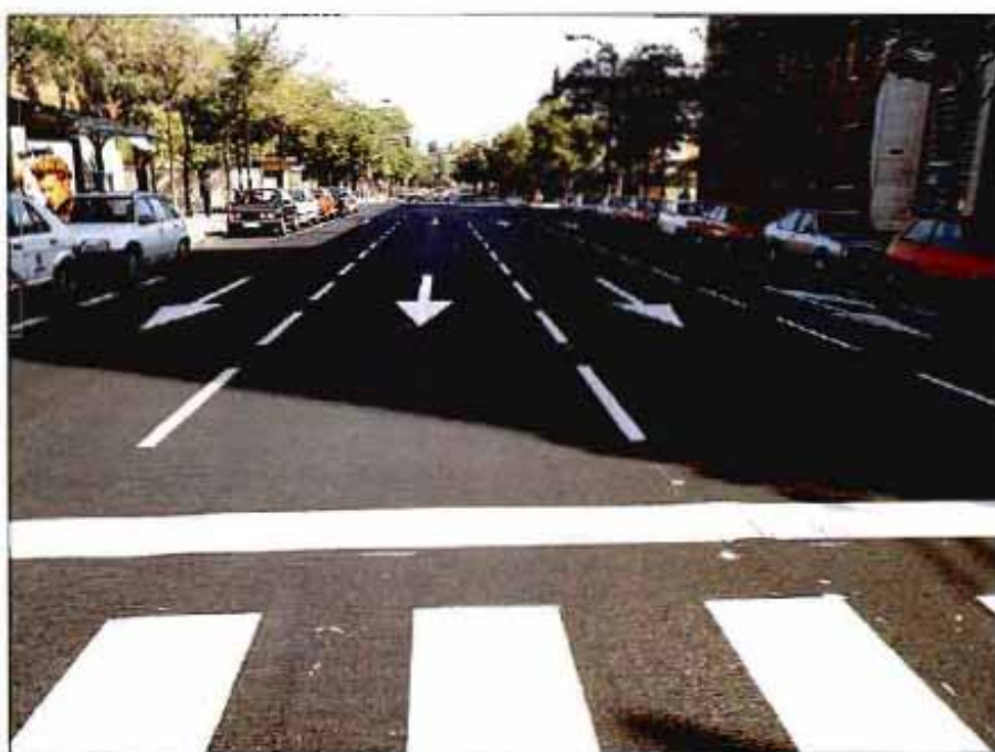
Foto 5. Aspecto general de un microaglomerado discontinuo en caliente utilizado como pavimento en una zona urbana de Madrid.
