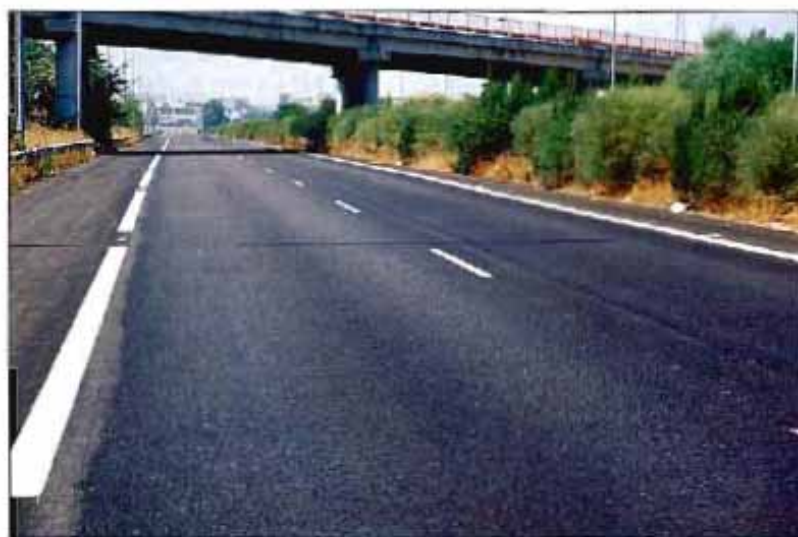
Foto 9 Mezcla drenante en frío ejecutada con emulsión ECM-m en la autopista Sevilla-Cádiz.
