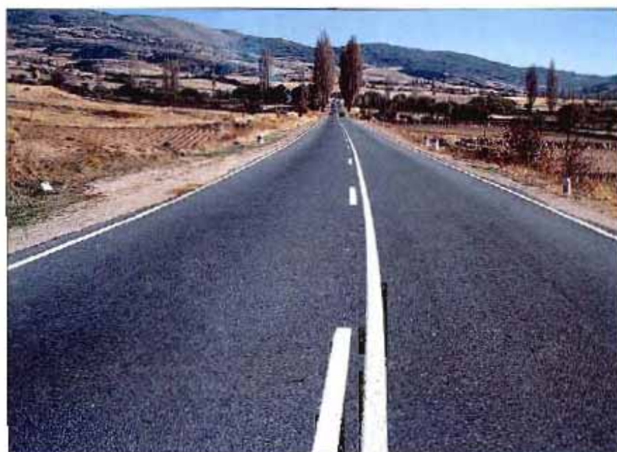
Foto 7. Aspecto final de un tratamiento superficial con gravilla fabricado con emulsión modificada ECR-3m
