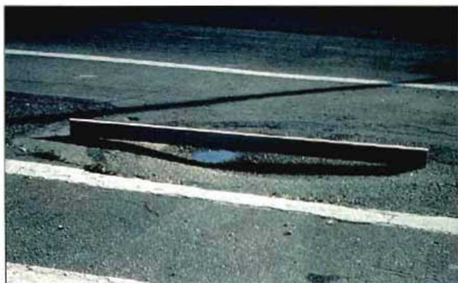
Figura 5. Bache en la calzada originado por un relleno incorrecto
