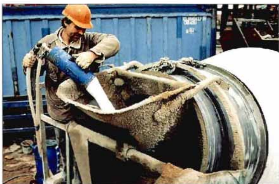
Figura 16. Adición de espuma preformada a un mortero.
