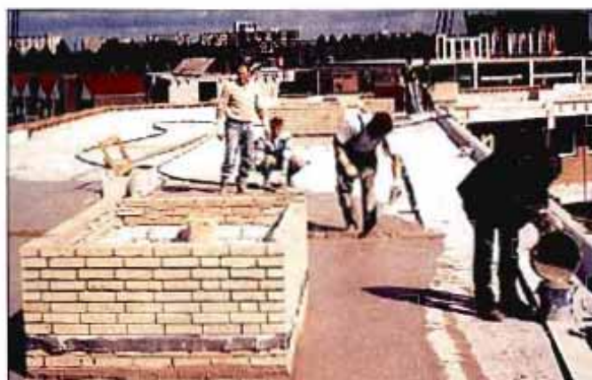
Figura 12. Formación de una capa aislante con mortero ligero en una cubierta.
