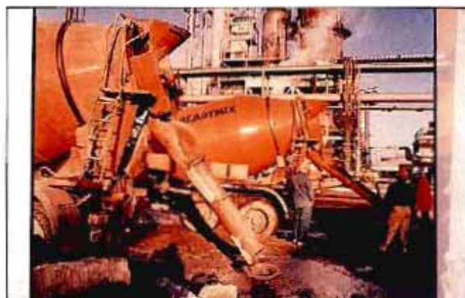
Figura 11. Relleno de un depósito subterráneo fuera de servicio.
