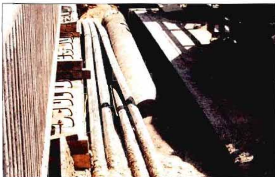
Figura 13 Relleno de una zanja para el alojamiento de canalizaciones en el tablero de un puente.
