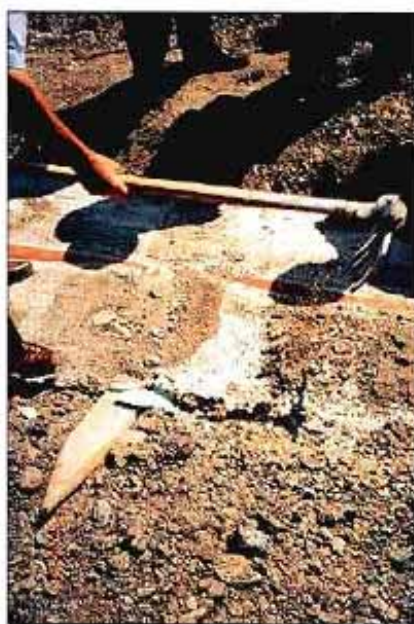
Figura 15. Excavación a mano de un material de baja resistencia controlada.
