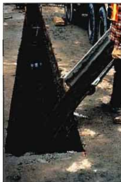
Figura 6a. Relleno de una zanja con mortero fluido: vertido directo desde camión hormigonera.
