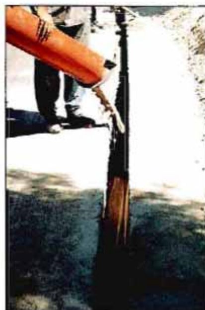
Figura 8. Relleno de una zanja estrecha para una canalización de gas natural
