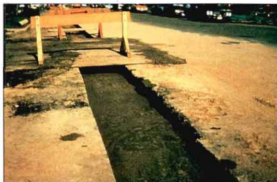
Figura 6b. Relleno de una zanja con mortero fluido: zanja con el material de relleno que alcanza la cota inferior del firme.
