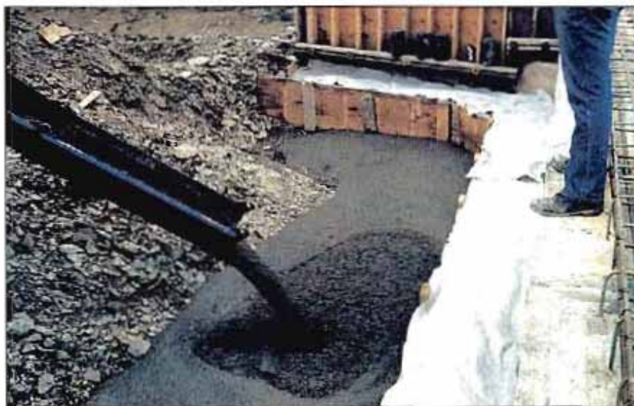
Figura 10. Relleno de un trasdós de estribo.
