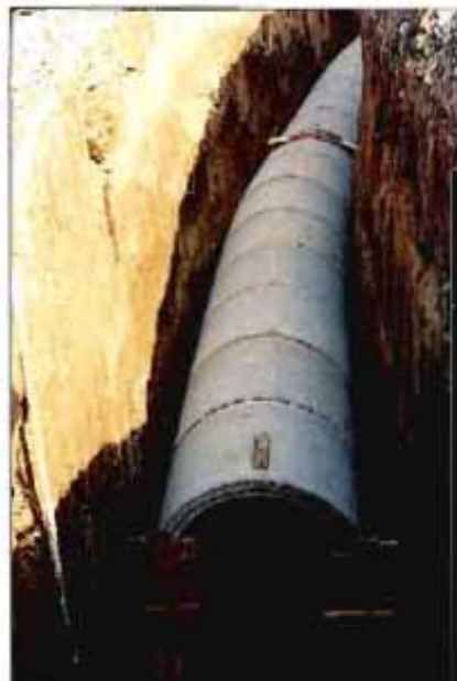
Figura 2. Espacio insuficiente entre la conducción y las paredes de la zanja, haciendo prácticamente imposible una compactación adecuada del material por debajo del plano medio.
