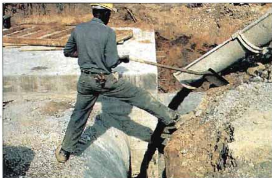
Figura 9. Relleno de una pequeña obra de fábrica
