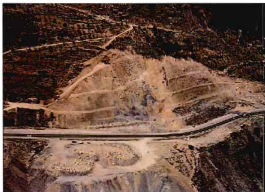
Foto 4.- Brecha de ladera de El Mirñaque, retaluzada y movida (zona geomorfológica D).
