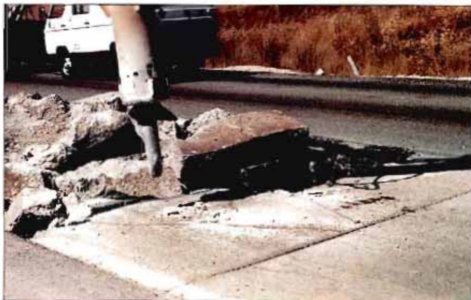
Recuperación de material de pavimentos de hormigón.
