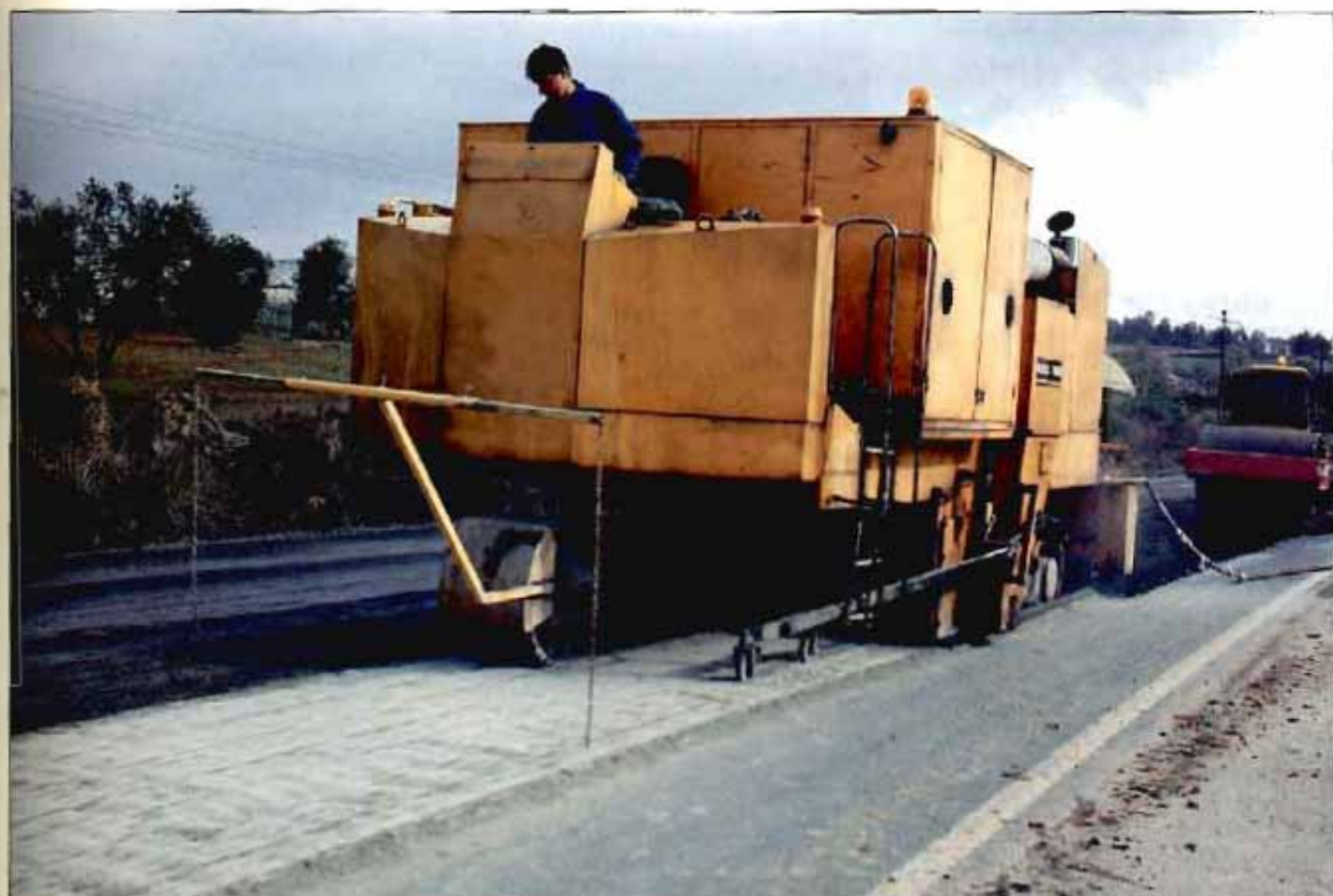
Reciclado in situ con cemento.
