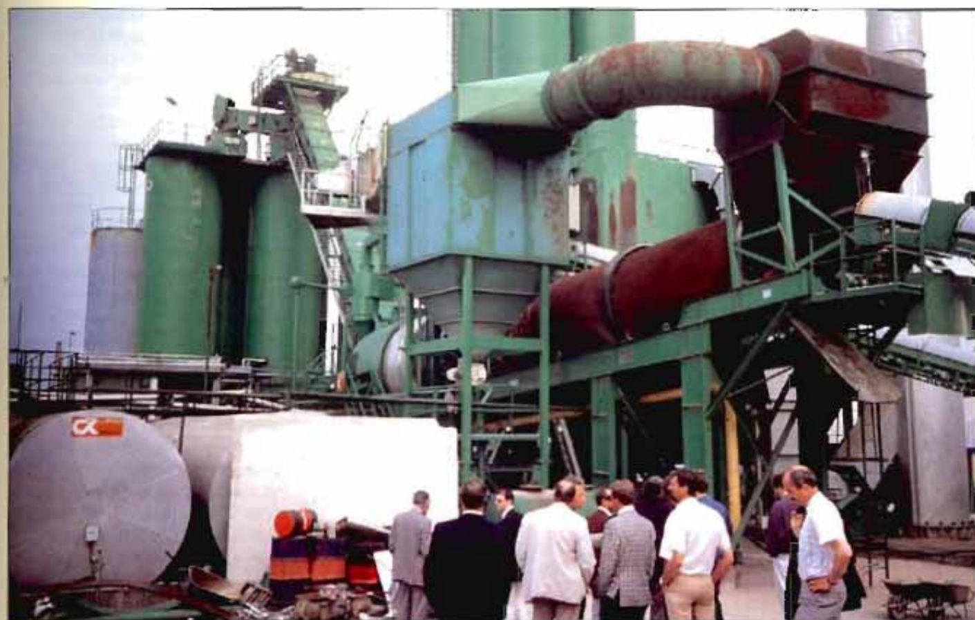
Central para reciclado de mezclas bituminosas en caliente
