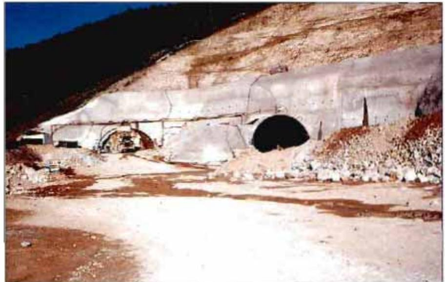
Inicio de excavación de la calzada izquierda en la boca del lado de Vigo.
