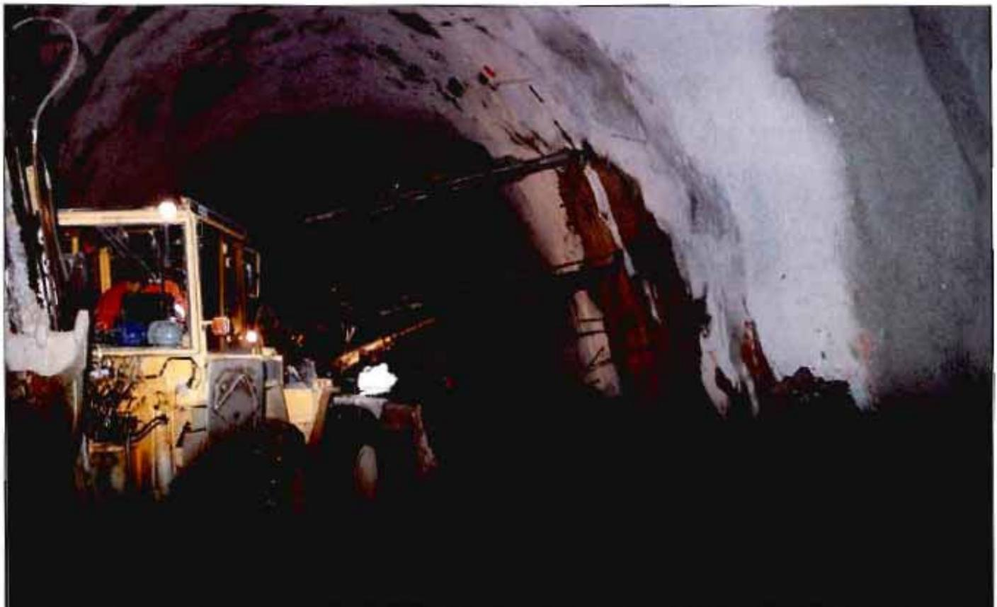
Perforando poraguas de bulones en el emboquillado de la galería de comunicación, p.k. 115+ 620 desde el túnel 2.
