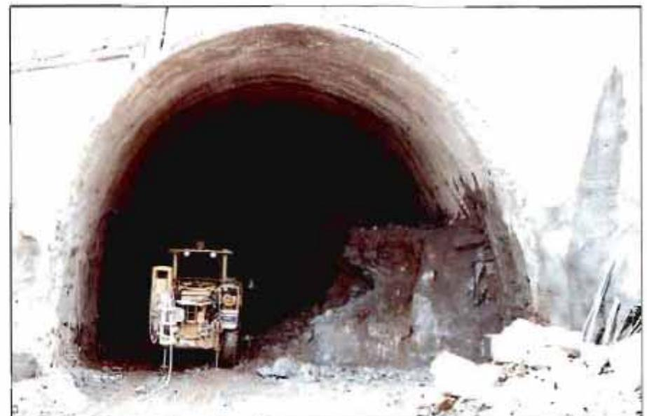
Excavación en la sección de destroza.
