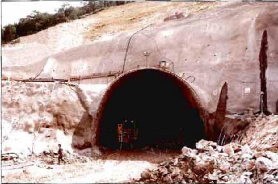
Vista del sostenimiento del talud frontal en la boquilla del lado de Vigo.
