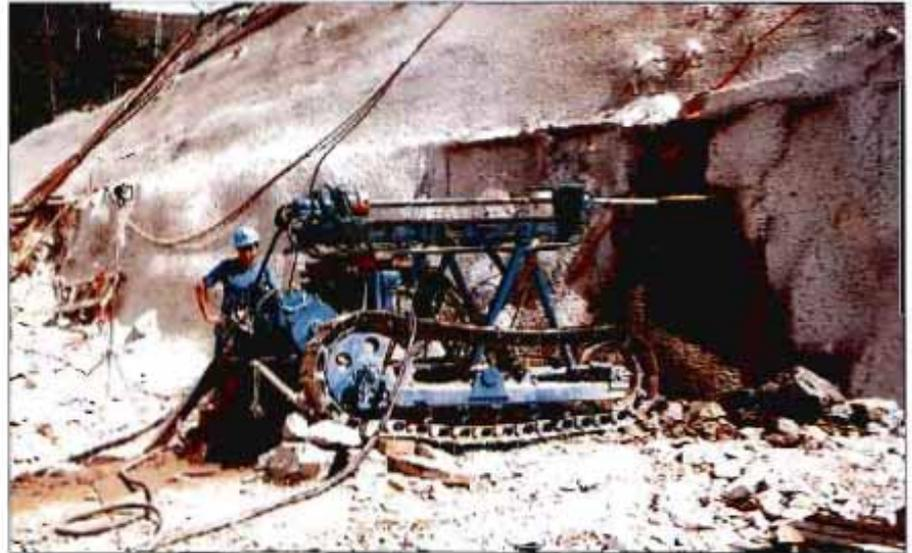
Ejecución del paraguas de micropilotes en las boquillas.
