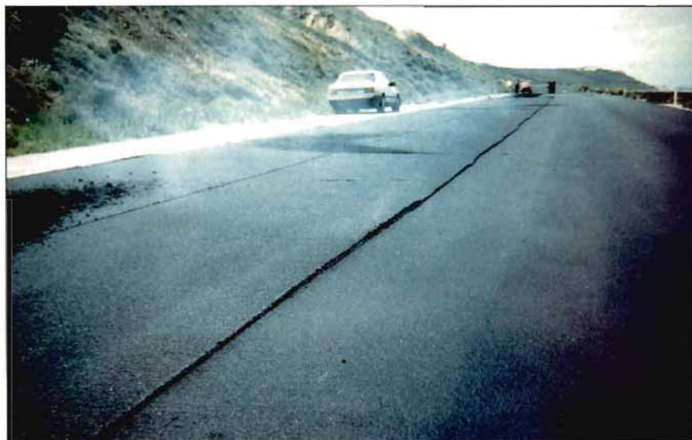
Detalle del producto terminado. Cortesía de la Autopista Vasco-Aragonesa.
