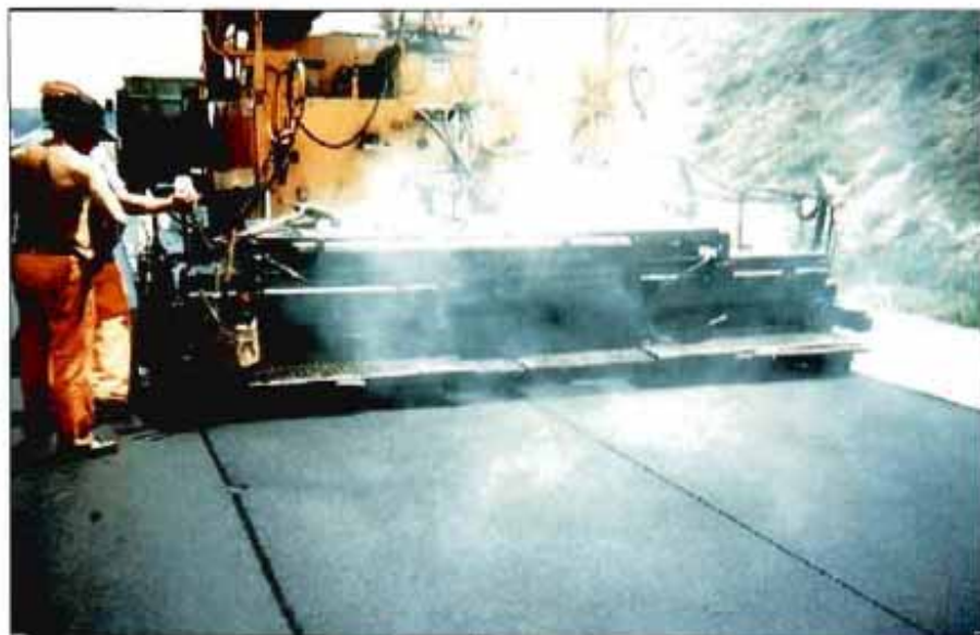
Extensión de una capa de arena-betún como tratamiento anti-reflejo de fisuras. Cortesía de Autopista Vasco-aragonesa.
