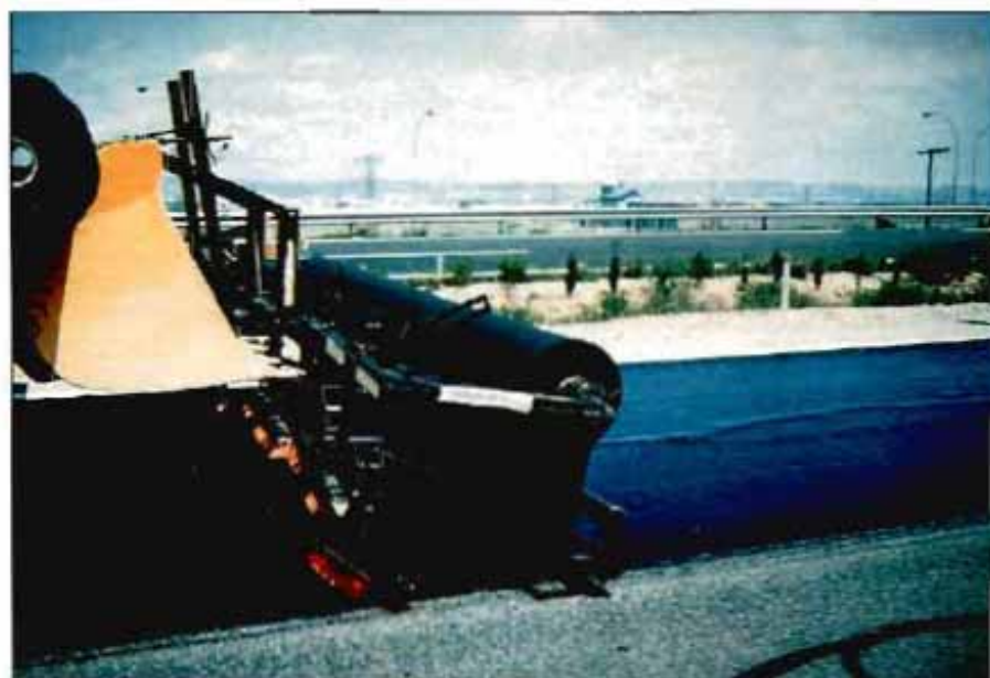
Extendido de un geotextil saturada como tratamiento antiirreflejo de fisuras.
