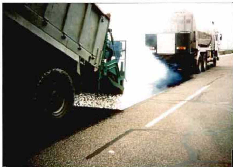
Extendido de una membrana "sarni" como tratamiento antirreflejo de fisuras.
