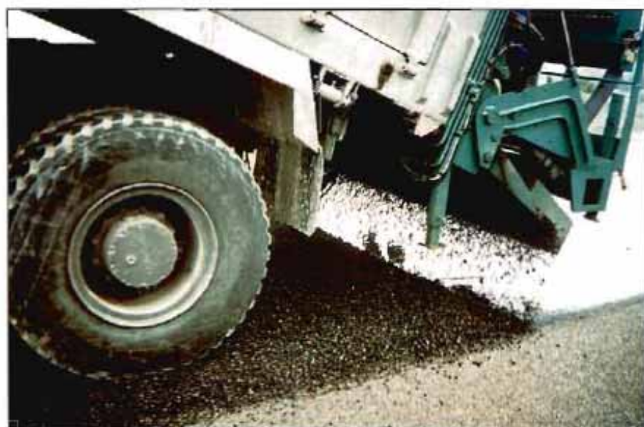
Detalle de la gravillada.
