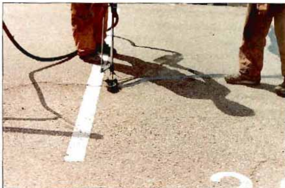
Detalle del sellado de fisuras por puenteo.
