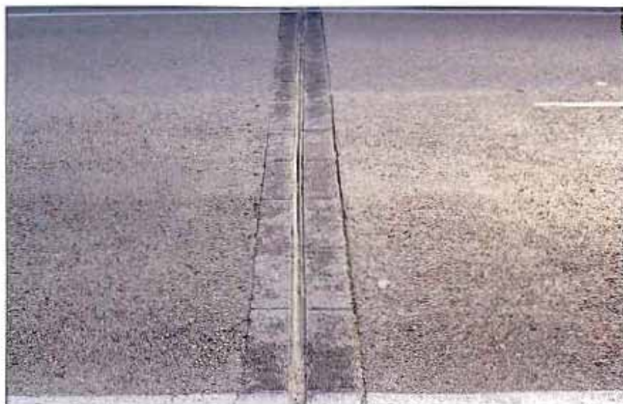
Figura 2. Pavimento de mezcla convencional tanto en el puente como en el resto de la carretera.
