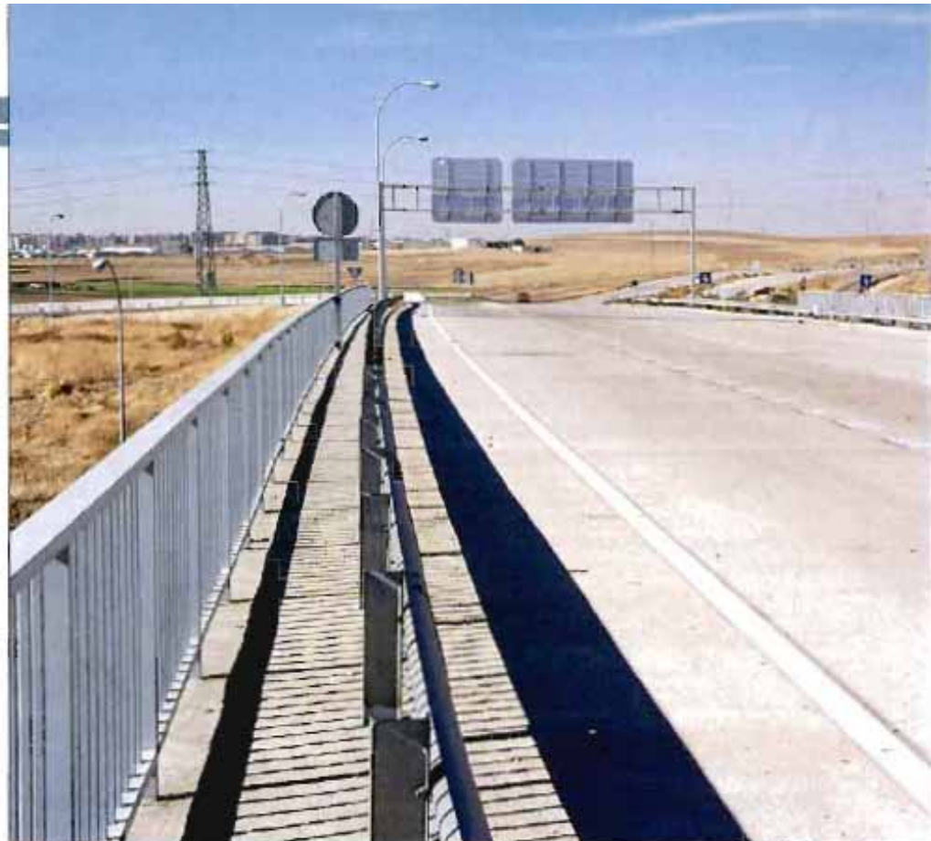
Figura 7. Pavimento de hormigón armado con fibras de acero en uno de los puentes del
