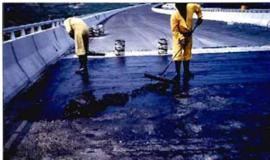
Figura 3. Ejecución de impermeabilización in situ con mortero bituminoso en frío.
