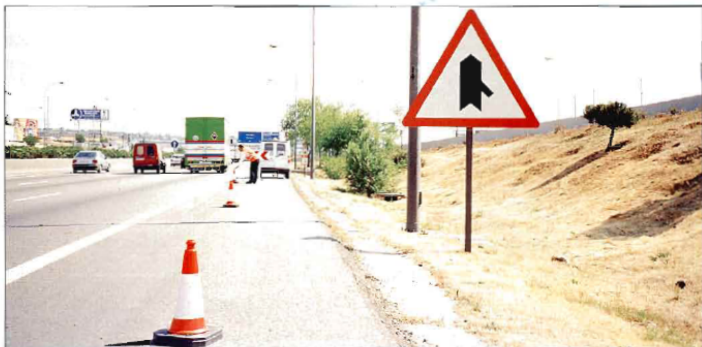
Al realizar la inspección visual en carreteras de gran circulación, deben aumentarse las medidas de seguridad
