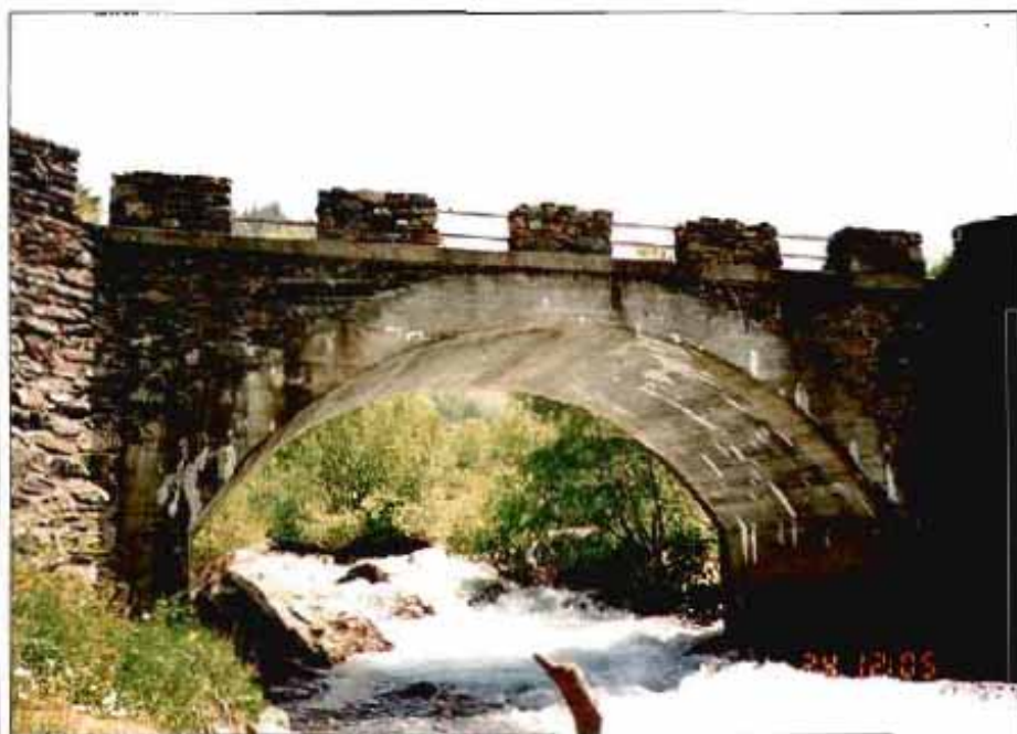
Puente arco con bóveda de hormigón en masa en el Pirineo catalán.
