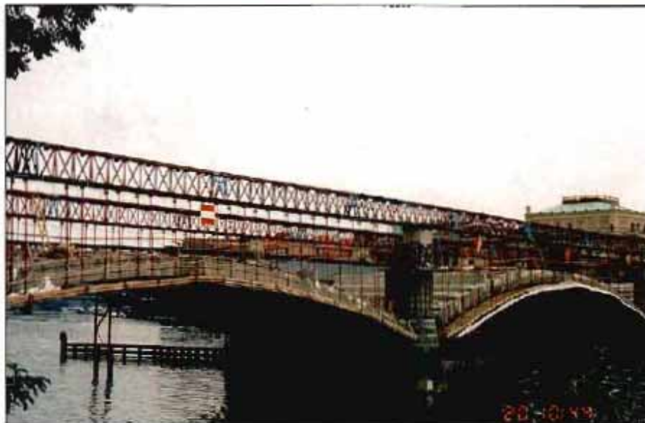
Raparación de un puente antiguo en la ciudad de Praga.
