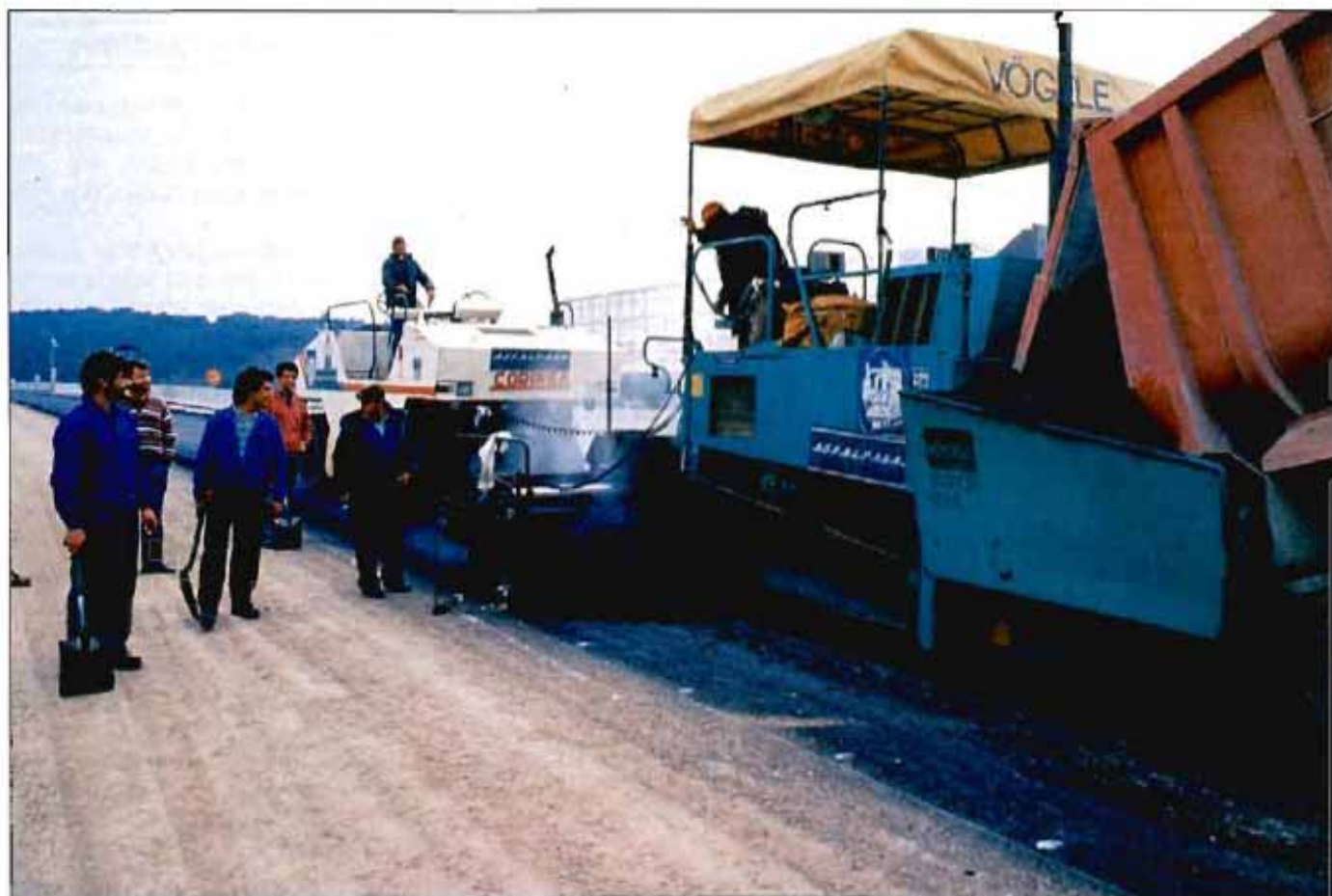
Detalle de ejecución de la capa.
