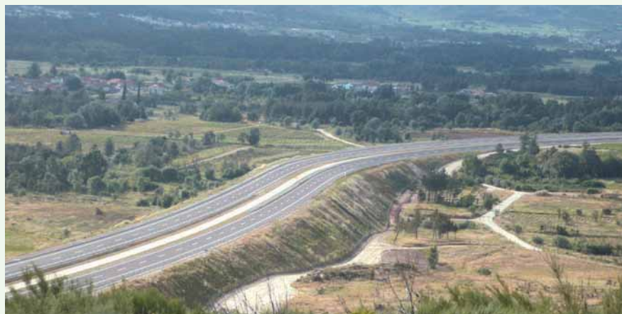
Terraplén, p.k. 5+400 al p.k. 6+600.
