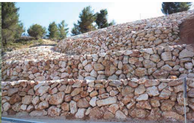
Vista aérea y detalle de los muros de escollera dispuestos en los pies de los taludes de desmontes para garantizar su estabilidad.
