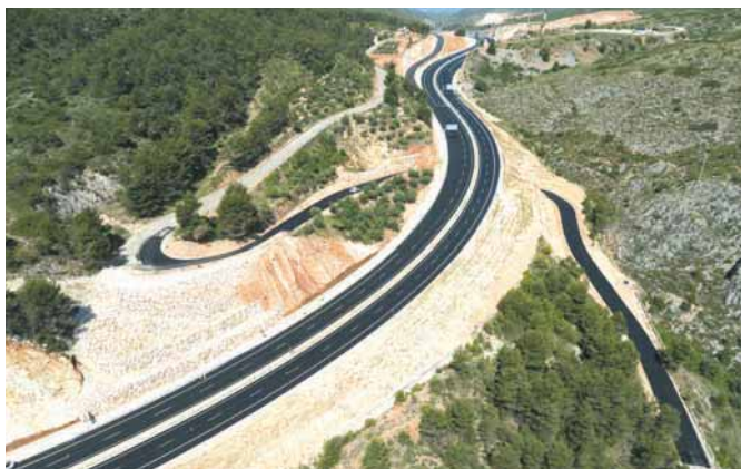
Vista aérea y detalle de los muros de escollera dispuestos en los pies de los taludes de desmontes para garantizar su estabilidad.
