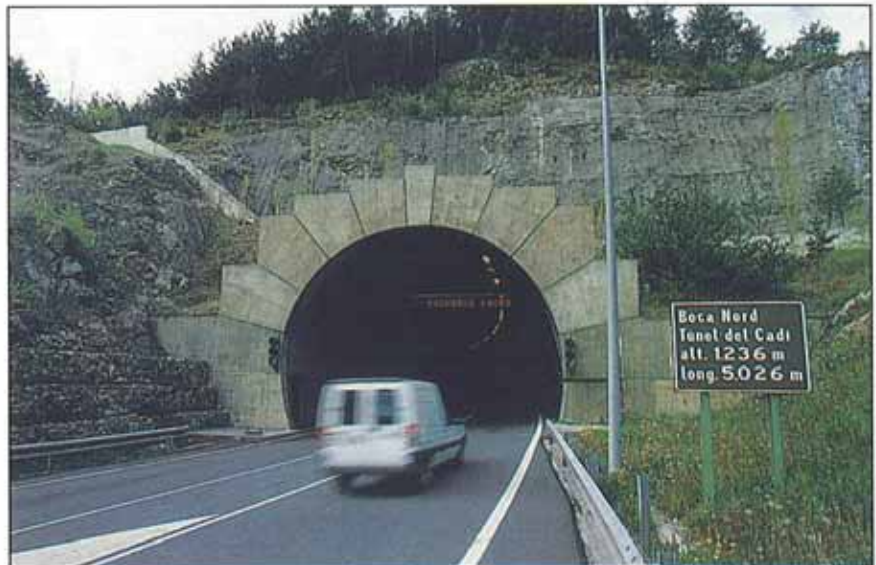
España tiene un total de 4 760 túneles con una longitud de 2 600 km.
