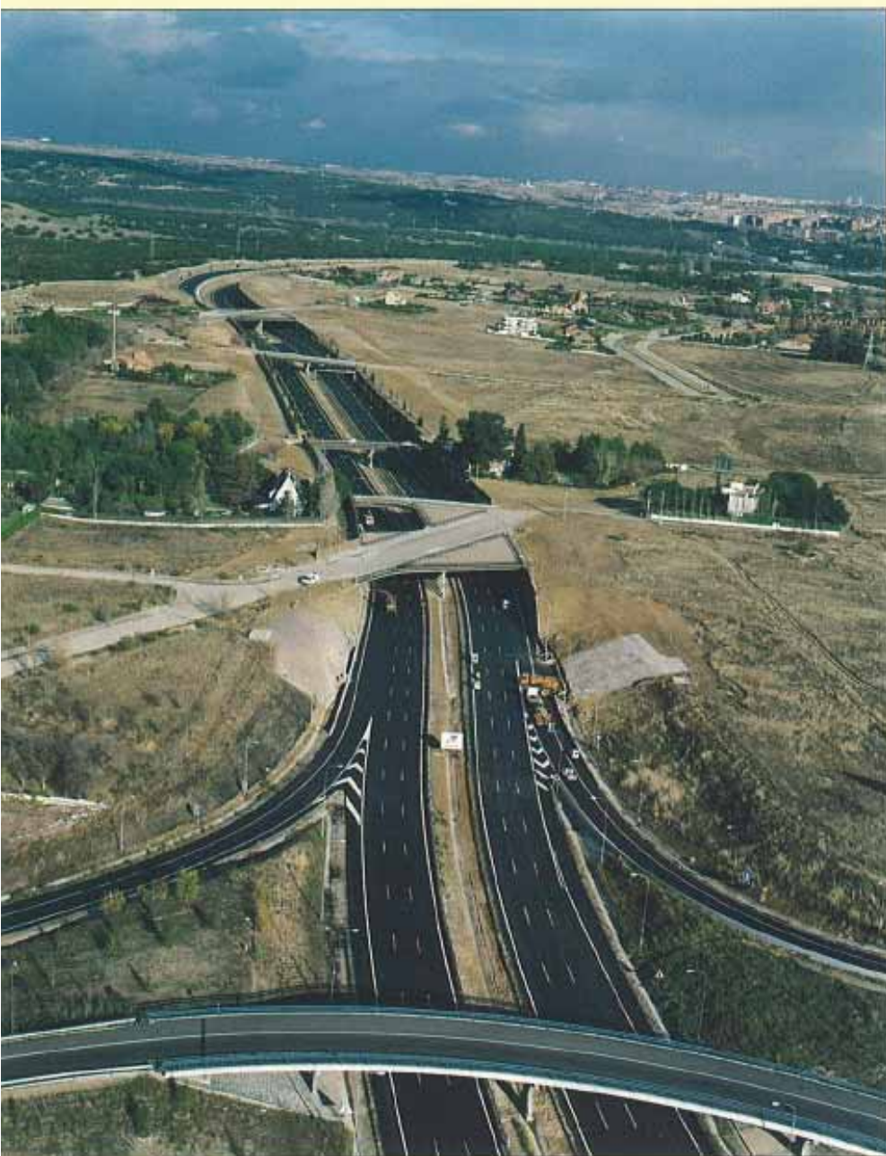
Distribuidor Norte M-40: Carretera N-VI - Enlace de la Zarzuela (Madrid) en su fase final de construcción.
