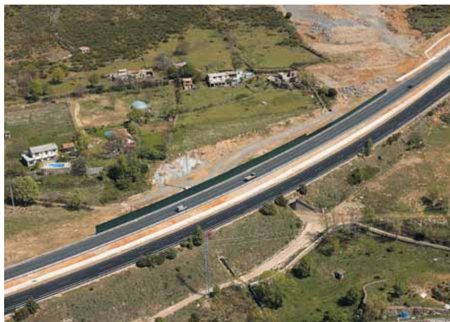
A lo largo del tramo se han dispuesto 13 pasos inferiores, 9 de ellos en reposiciones de caminos.
