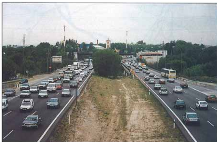
La mediana prevista en los nuevos tramos permitirá la ampliación a cuatro carriles por calzada sin acometer nuevas expropiaciones.
