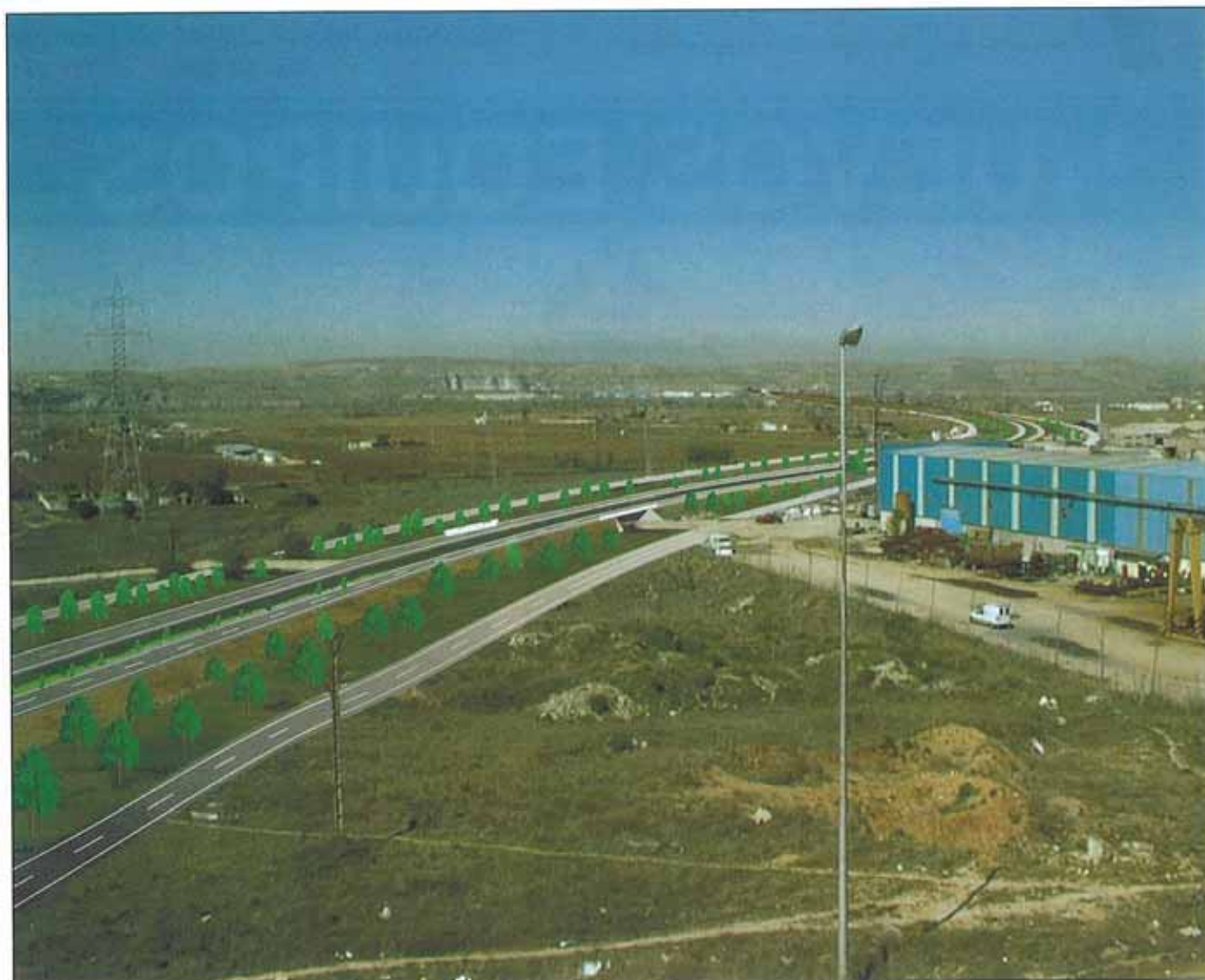
Vista desde el polígono industrial de Mejorada, donde la nueva radial R-3 aprovecha la reserva viaria y atraviesa el Parque Regional por zona F (periférica de protección).
