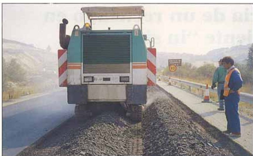
Fresado de un carril.
