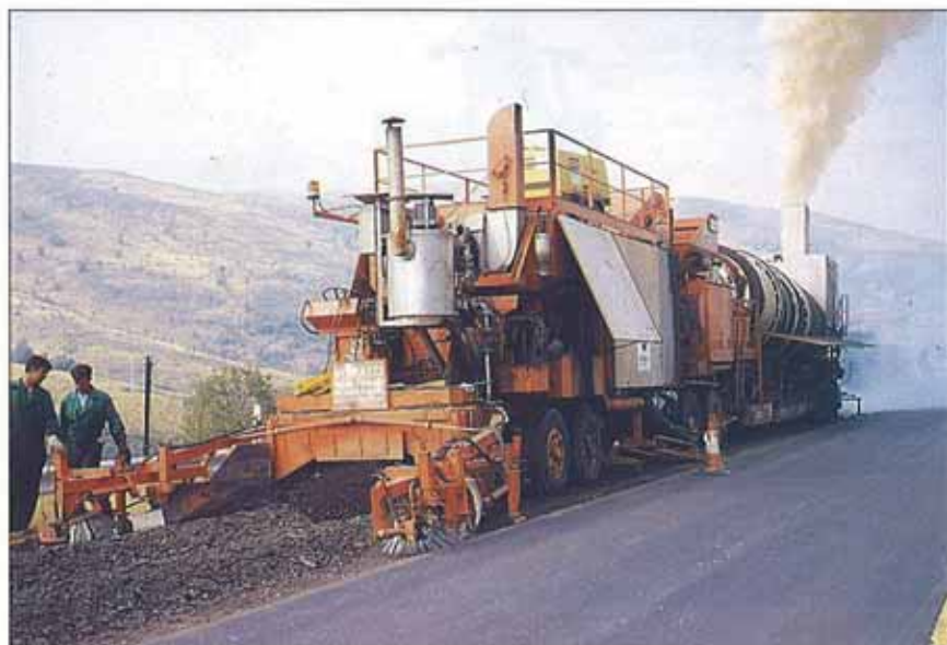
Vista de la máquina ART. Recuperación del material fresado.
