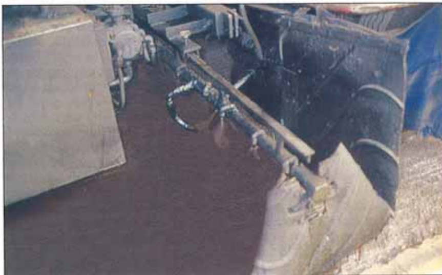
Riego de adherencia.
