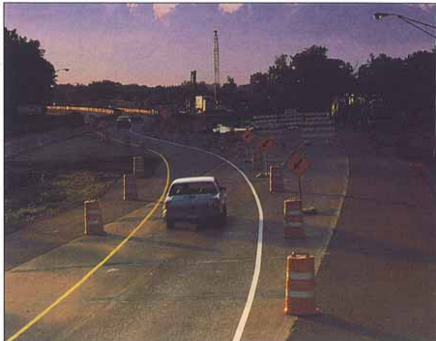
Una correcta señalización reflectante por obras garantiza una mínima seguridad para el conductor ante esta eventualidad.
