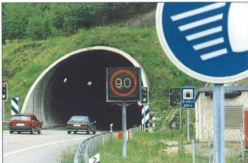
Ejemplo de señalización a la entrada de los túneles de Padrún.
