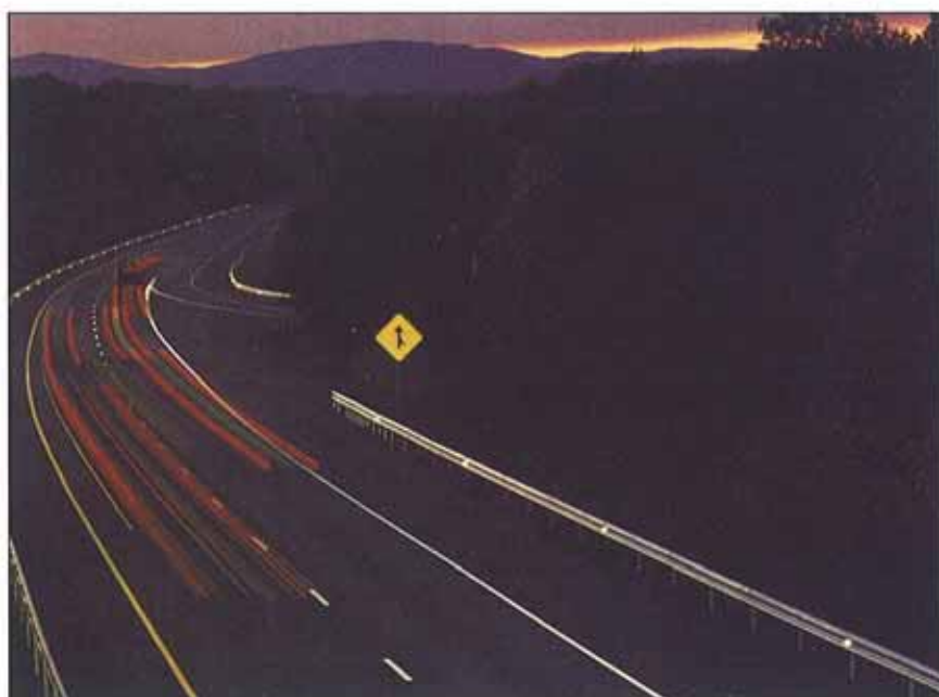
Ejemplo de buena reflectancia de la señalización en tramo interurbano.
