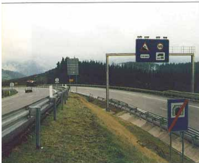
Panel informativo fijo en una autopista española. Nótese los puntos de luz en la parte superior del panel para su correcta visualización.
