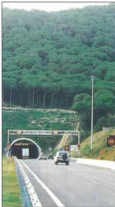
Señalización vertical a la entrada del túnel de Papiers.
