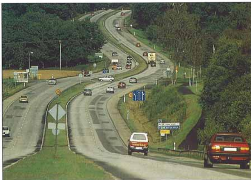
Se hace patente la necesidad de armonizar los elementos de seguridad que equipan la vía.
