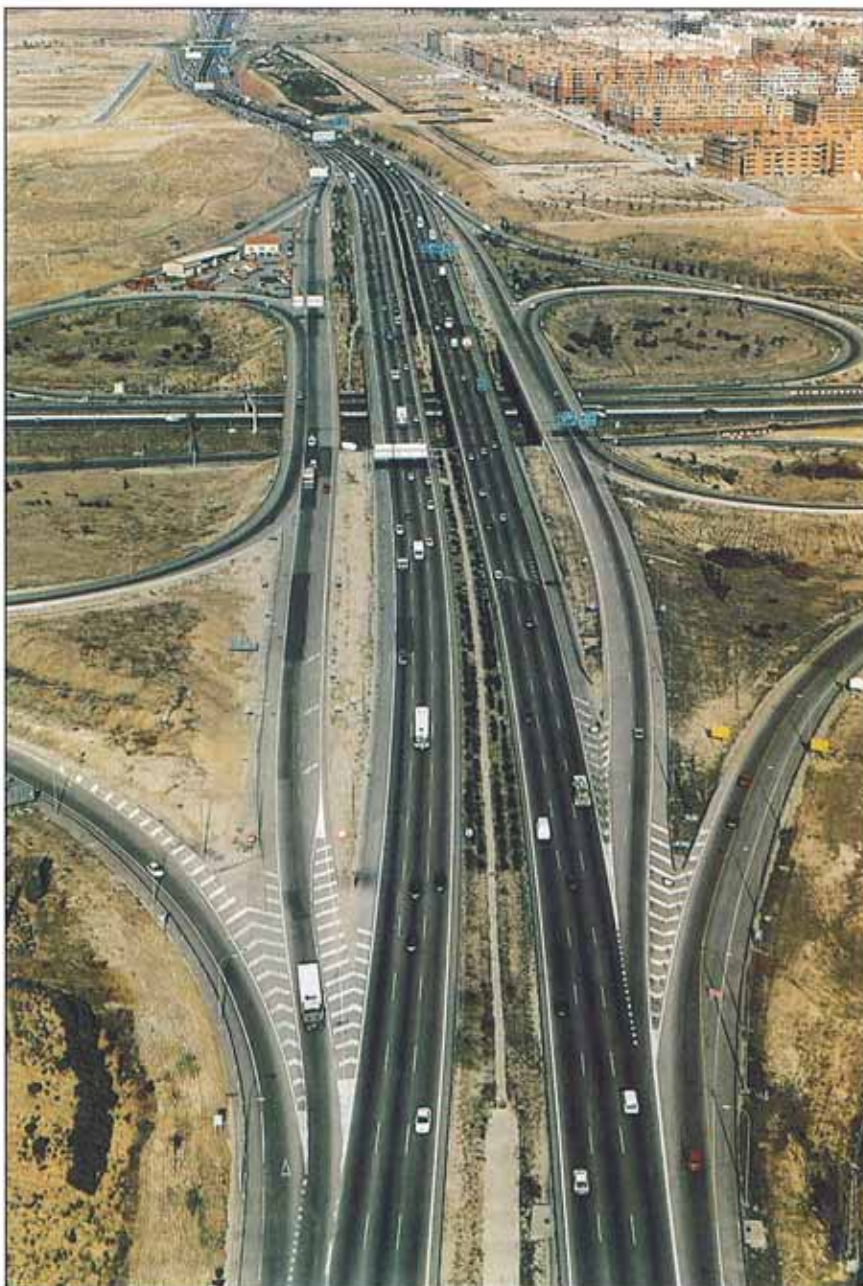
La calidad en la señalización horizontal y vertical contribuye de forma efectiva a la seguridad vial.
