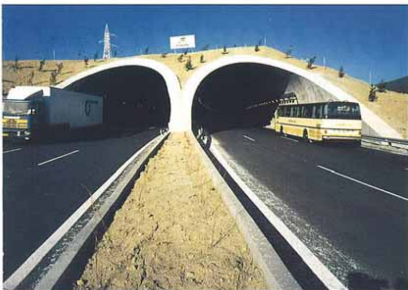
Otra de las innovaciones de la Norma, es la exigencia de 5,0 m de gálibo en túneles y en toda la plataforma.
