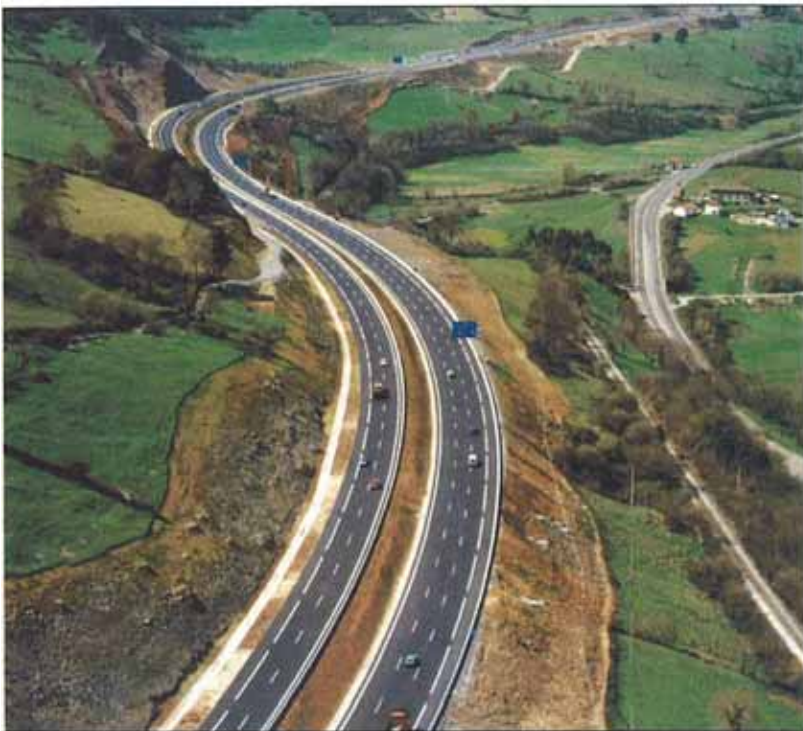
Entre las novedades más importantes de la Norma está la incorporación de los conceptos de autovía y vía rápida.
