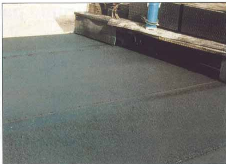
La ejecución física de los trabajos se realiza por empresas privadas.
