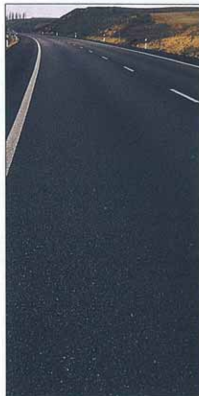
En las obras sin restricciones presupuestarias, la asignación de prioridades se hará en función del momento de la ejecución.
