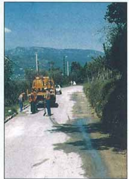
Trabajos de reparación y drenaje.
