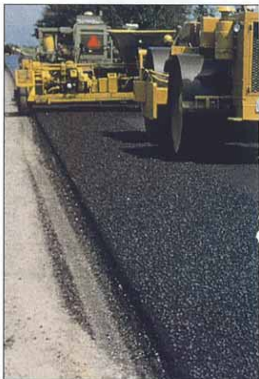
Extendido de capa bituminosa.
