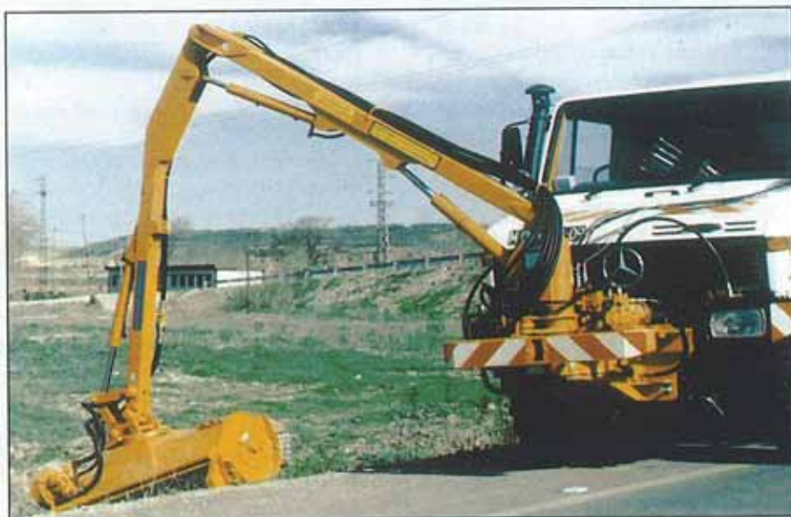
Trabajos de conservación.
